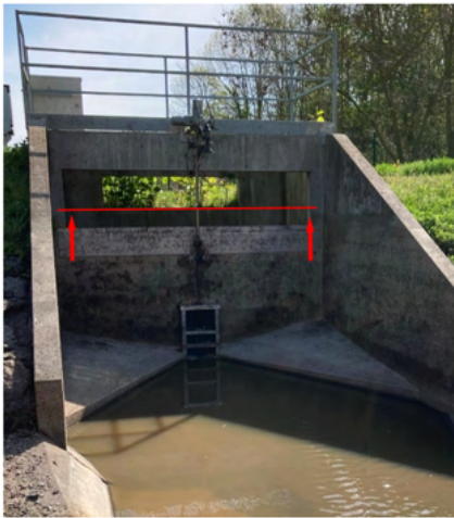
Fig. 47 – Rehaussement de la lame de déversement du bassin de Terrenoire : illustration et tableau des deux relations hauteur d'eau - débit déversé implémentés dans le modèle. Photo : Frédéric Jordan.
