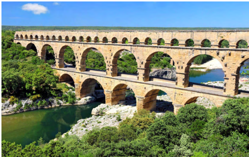
Fig. 1 – Vestige d'un aqueduc romain, témoin d'une gestion intelligente de l'eau. [28]
