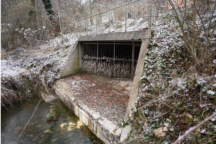
Photographie A : Rejet du déversoir d'orage de la Motta. Les grilles sont recouvertes de déchets solide provenant des eaux usées.
