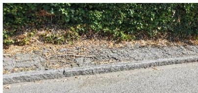
Figure 149 Irrégularités du trottoir à cause de la nature, Chêne-Bourg, Bel-Air
