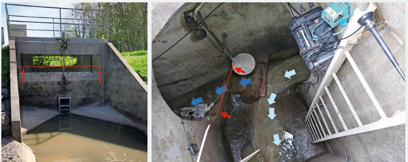
Fig. 8 Photographies du seuil fixe de déversement du BO Terrenoire et du DO Lafayette. En rouge les aménagements proposés.
