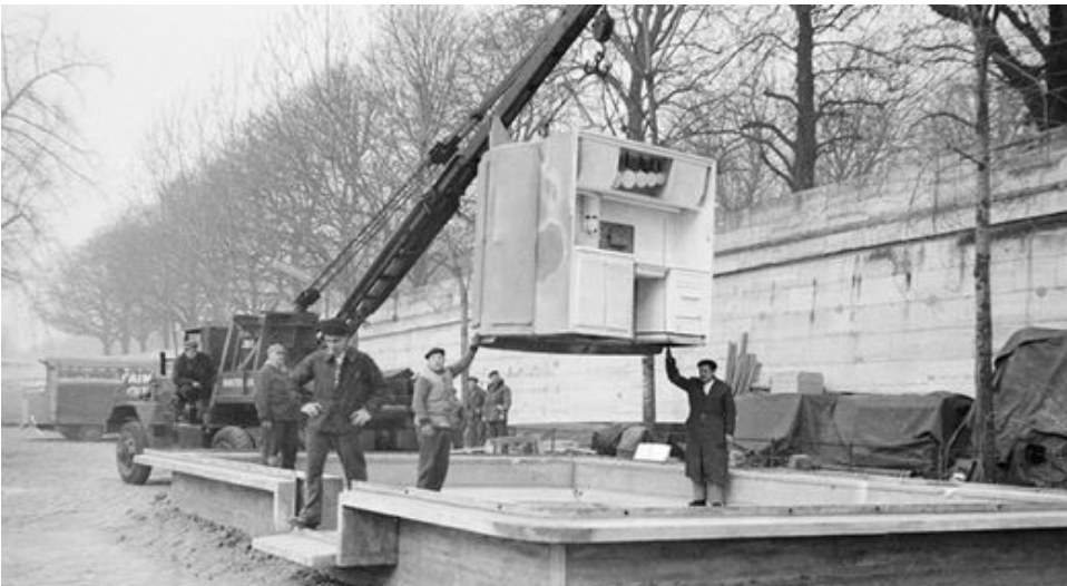
8 Construction site of the Maison Des Jours Meilleurs Paris, 1956
