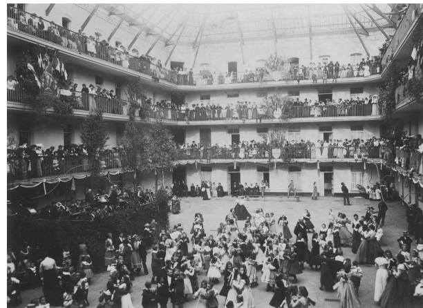
Fig. 7 : Plan de situation du Familistère. Fig. 8 : Vue cavalière du Familistère projeté. Aquarelle anonyme, vers 1859. Source: Collection Familistère de Guise. Fig. 9 : Le bal de la fête de l'Enfance dans la cour du pavillon central du Palais social, Photographie anonyme, 1909. Source: Collection Familistère de Guise.
