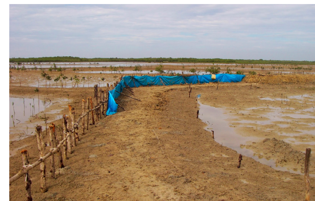
Construction d'une digue à Niomoune au Sénégal, auteur inconnu
