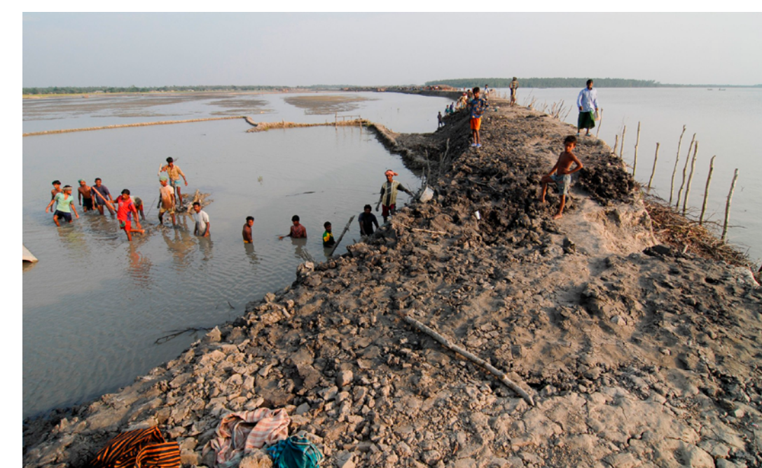
Construction d'une digue à Kalabogi au Bangladesh © Joerg Boethling
