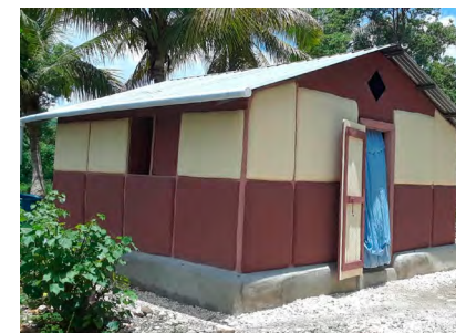
Enduit des façades © Ojucah Haïti
