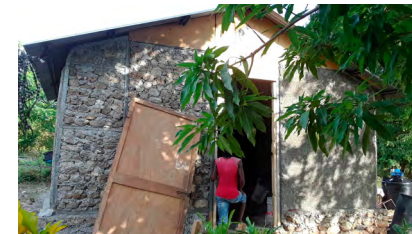
Remplissage en maçonnerie © Ojucah Haïti
