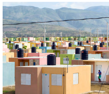
Construction permanente du village Lumané Casimir, Haïti, 2014 © Corentin Fohlen
