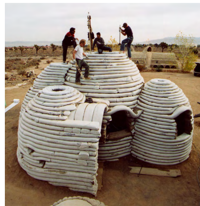
Construction d'un Eco-Dôme © Taflin Laylin
