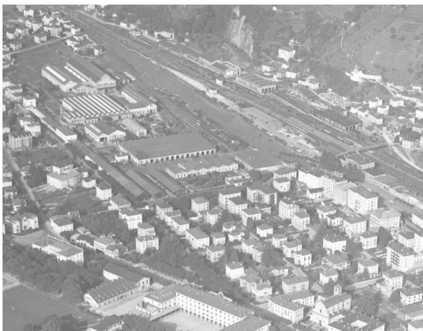
Fig. 81 ▶ Vue Aerienne Ateliers CFF En bas à Droite le quartier de San Giovanni, 1946
