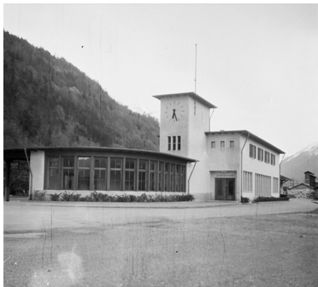
Fig. 88 ► Gare de Flüelen
