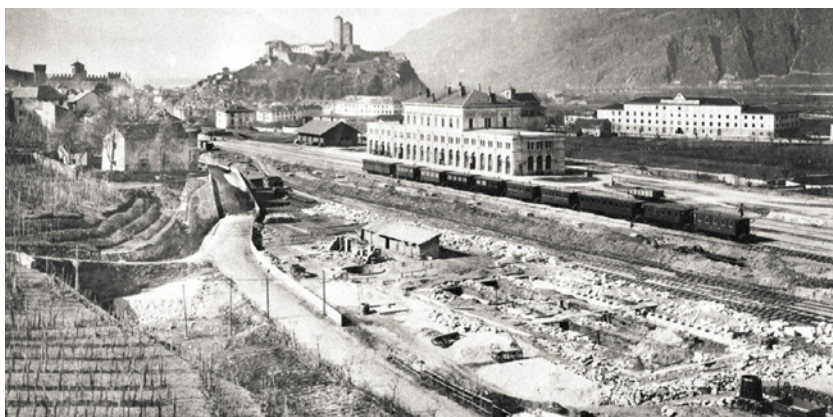
Fig. 78 ► Excavation pour les premiers entrepôts 1875
