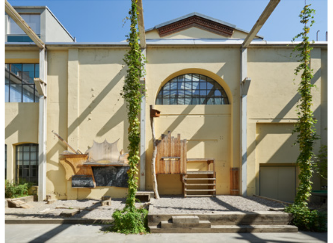
▲ Fig. 16 Façade Sud Halle 8
