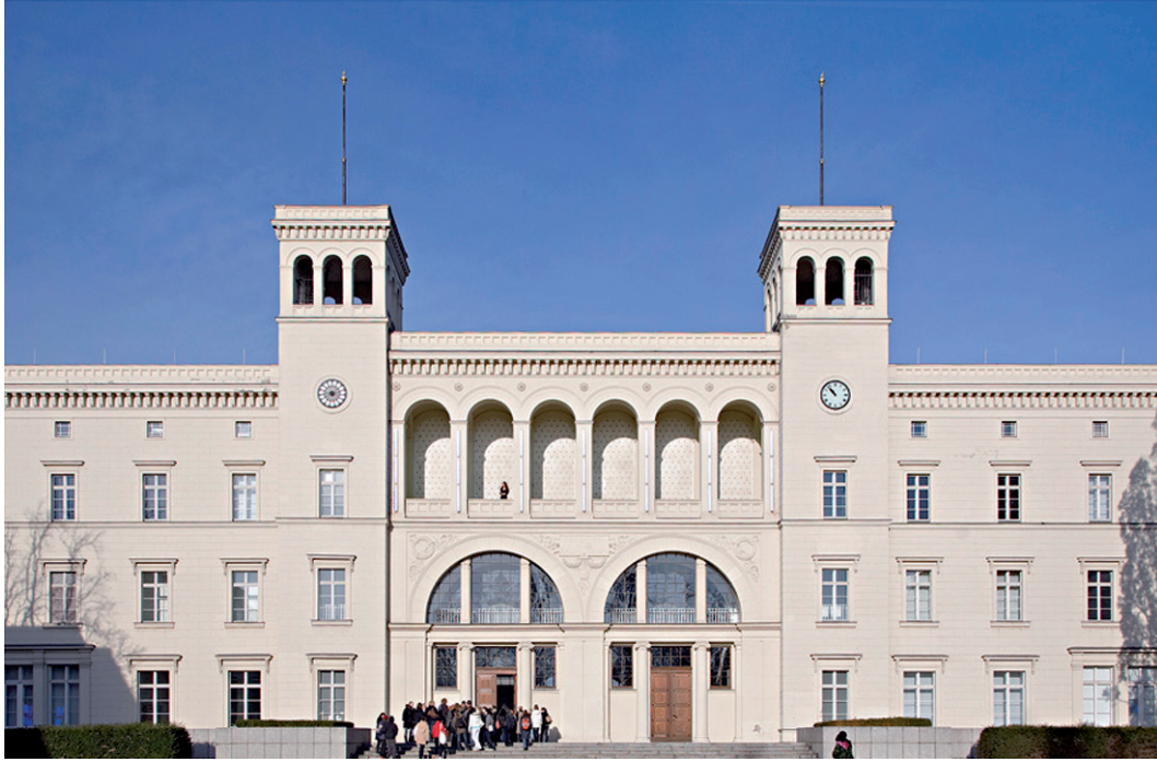
▲ Fig. 21 Façade Sud-Est Entrée
