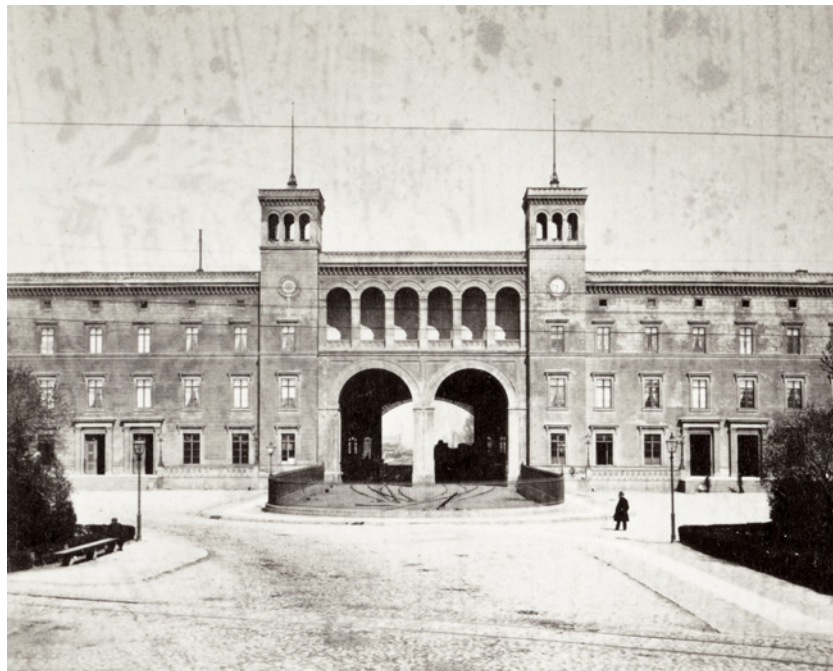
Fig. 45 ► Façade Hamburger Bahnhof 1868
