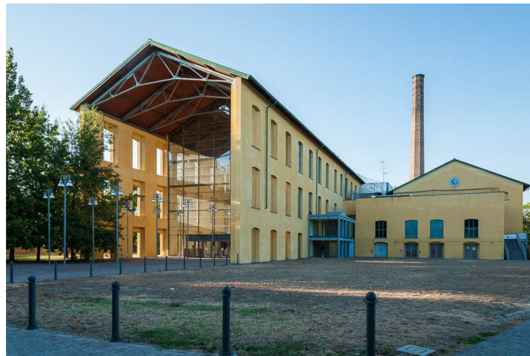
▲ Fig. 28 Vue sur l'entrée et l'ensemble est
