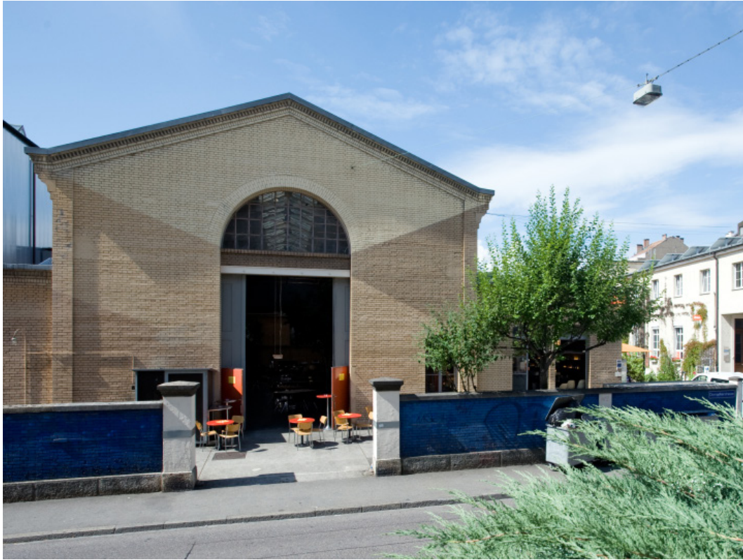
▲ Fig. 15 Façade nord Halle 8 Entrée Restaurant
