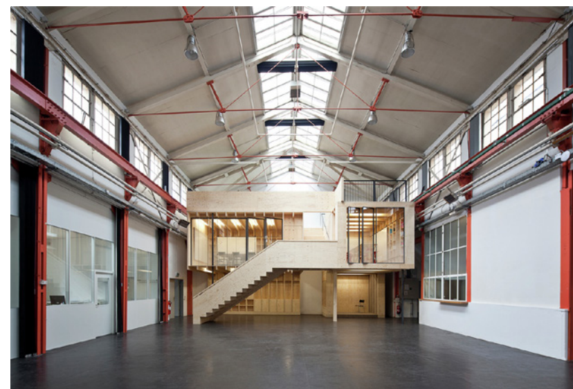
◀ Fig. 38 Launchlab Gundelgingerfeld Structure secondaire en bois
