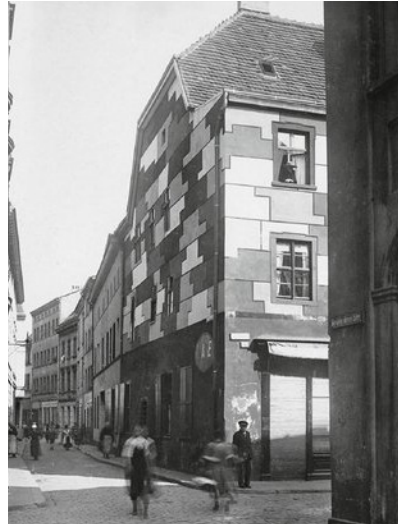
Fig.64 Carl Krayl, composition de couleurs sur une façade de Peterstrasse, Magdebourg, photo 1922
