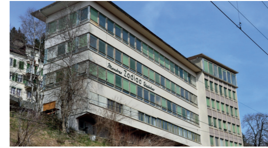
Usine Zodiac avant les travaux de rénovation
