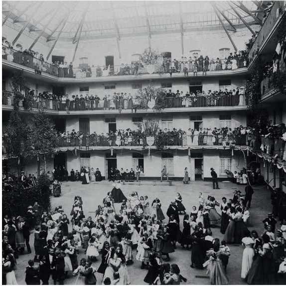
Figure 5. Vue intérieure de l'espace collectif couvert
