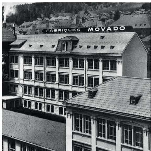
Figure 9. Paysage industriel de la Chaux-de-Fonds
