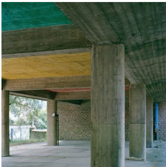
Figure 24. Colorimétrie des plafonds / dalles en béton à l'extérieur sous les pilotis
