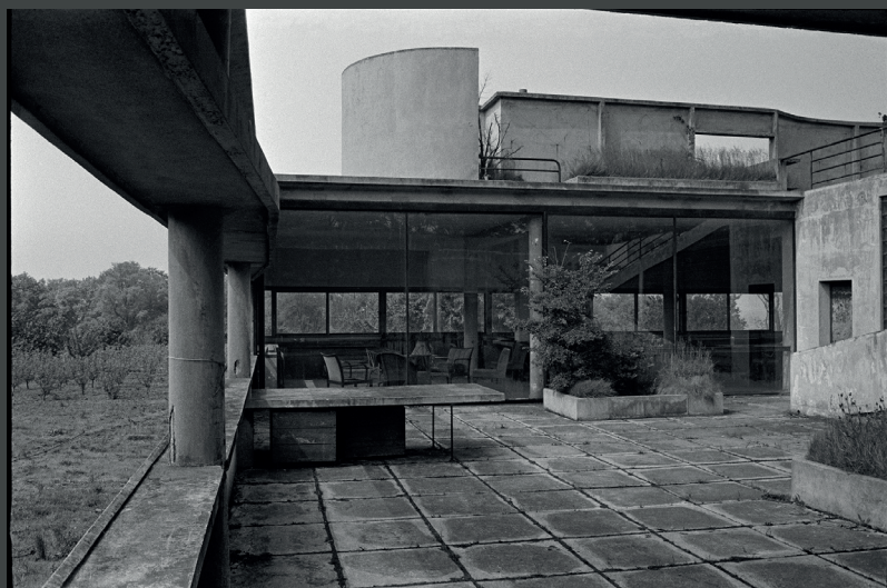
Toiture de la villa Savoye, Le Corbusier, 1931
