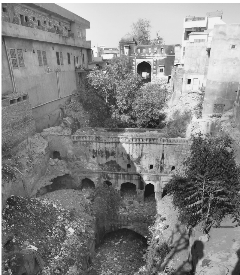
13 Bâoli anonyme, à Fatehpur. Dans beaucoup de villages, les puits moins connus sont abandonnés car les nouvelles canalisations empêchent l'eau d'arriver dans le bassin du bâoli . Au fil des années, certains se sont remplis de déchets jusqu'à être totalement ensevelis.
