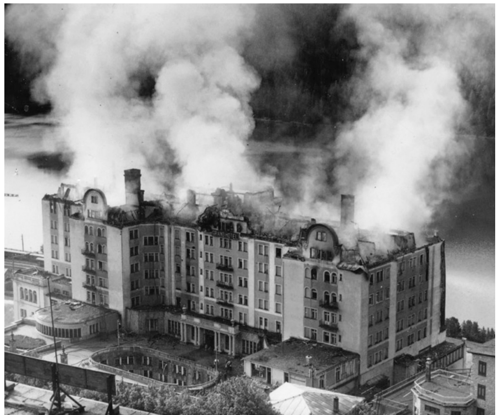
Fig.3 Le Grand Hôtel de St Moritz après l'incendie du 30.06.1944. Source : photographie Albert Steiner.
