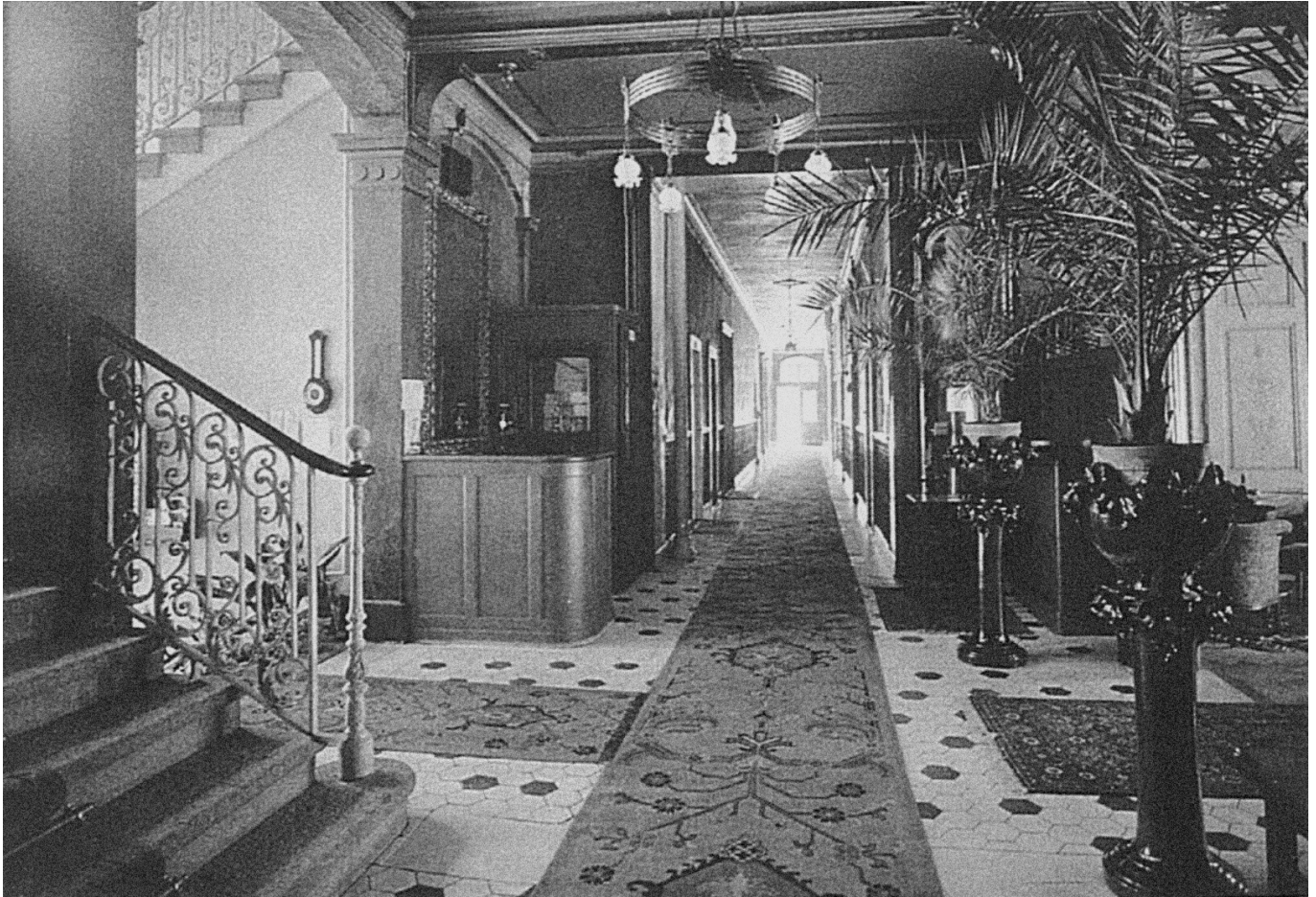
Fig. 27 Vevey, Park Hôtel Mooser. Exemple caractéristique d'un hôtel avec un plan linéaire et des chambres disposées des deux côtés du couloir. Photo- graphie du ca.1890. Source : Flückiger-Seiler, Ro- land. Hotelpaläste : zwischen Traum und Wirklichkeit : Schweizer Tourismus und Hotel- bau, 1830-1920. 2., korrigierte Aufl. Baden: Hier + Jetzt Verl. für Kultur und Geschichte,2005.
