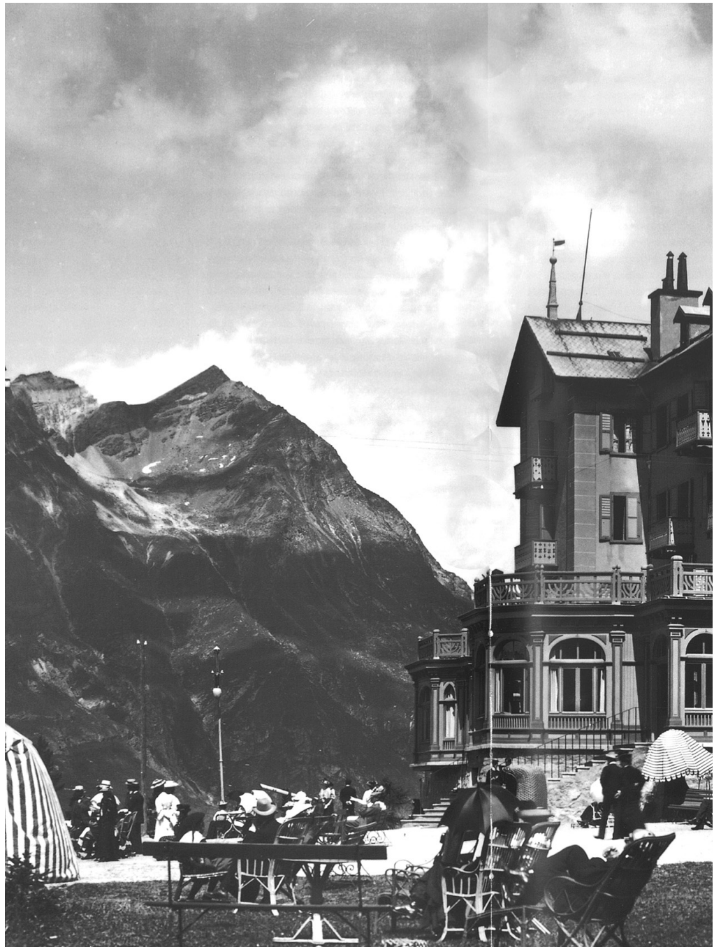
Fig. 9 Vue depuis la terrasse de l'Hôtel Riffelalp à Zermatt. Photographie de 1910. Source : Flückiger-Seiler, Roland. Hotelträume zwischen Gletschern und Palmen : Schweizer Tourismus und Hotelbau 1830-1920 . 2., korrigierte Aufl. Baden: hier + jetzt, 2005.
