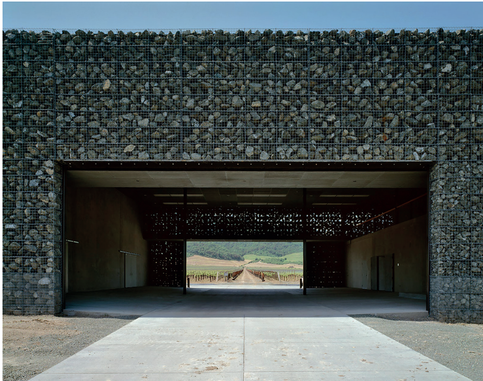
Illustration 7: Accès au vignoble Dominus traversant la bâtiment en gabions © Courtesy of Architekturzentrum Wien, Collection/Margherita Spiluttini.
