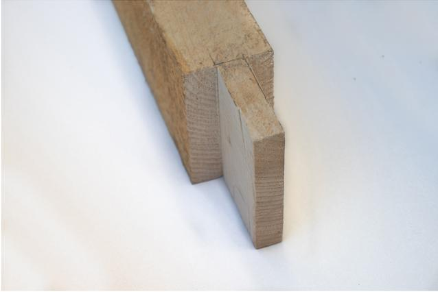
Figure 24: La partie tenon découpée dans le montant
