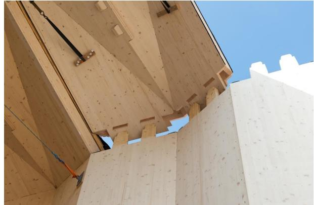
Figure 8: Pavillon de Vidy : assemblage par emboitement
