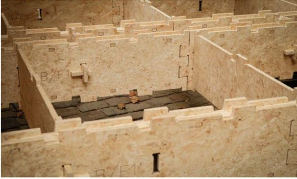
Figure 11: Les fondations d'un projet Wikihouse, construit lors du London Design Festival
