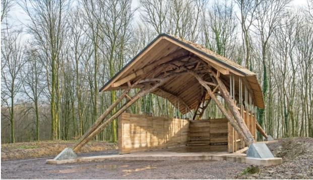
Figure 59: Projet Wood Chip Barn, réalisé par les étudiants de AA à Hooke Park. Ce projet est un treillis spatial grâce à la géométrie des 25 fourches d'arbres scannées et implantées selon leurs valeurs géométriques et structurelles.
