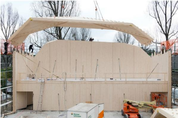
Figure 7: Pavillon de Vidy : Montage d'un élément préfabriqué
