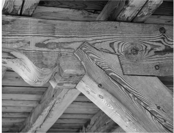
Figure 2 Exemple de connexion sans connecteurs réalisé par Chalets Mossaz
