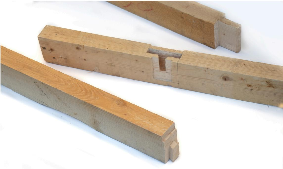
Figure 3 Les pièces qui constituent l'assemblage Ari-kake
