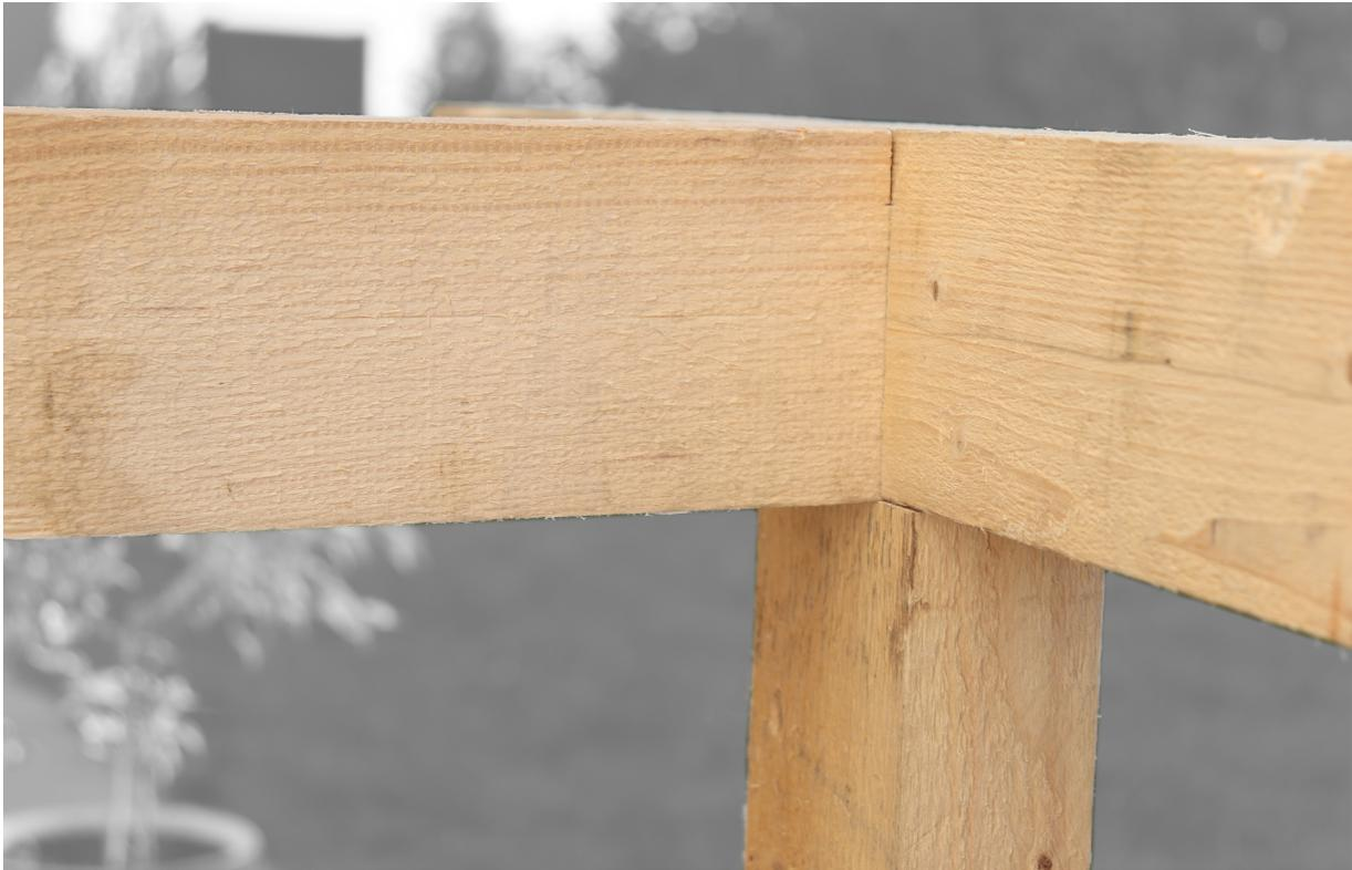
Figure 4: L'assemblage Ari-kake dans son état complet
