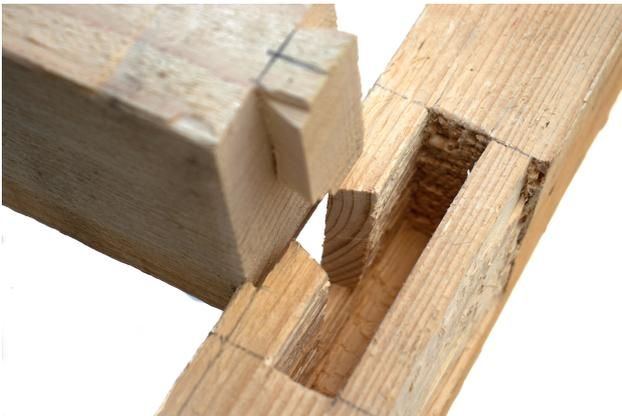
Figure 28: Première étape : insertion de l'aronde dans la contre-queue
