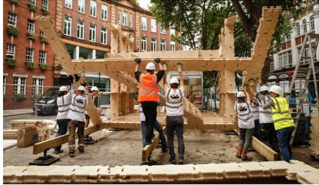
Figure 12: Assemblage et montage des éléments sur place
