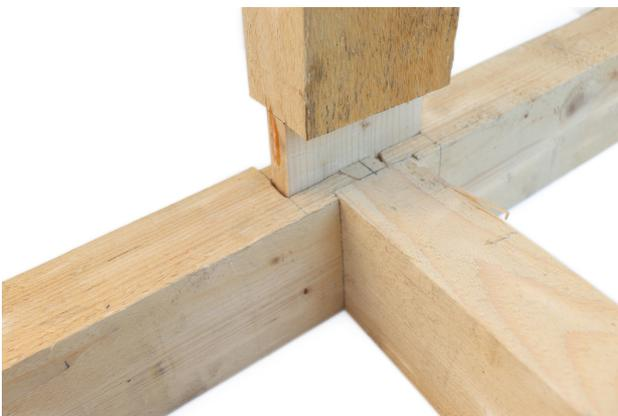
Figure 30: Deuxième étape : insertion du tenon dans la mortaise
