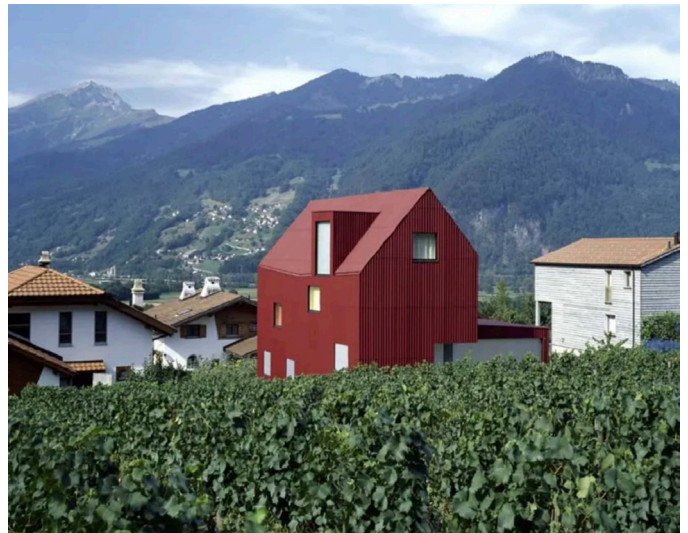
Maison Walther, Malans, 2002 Architectes: Bearth & Deplazes
