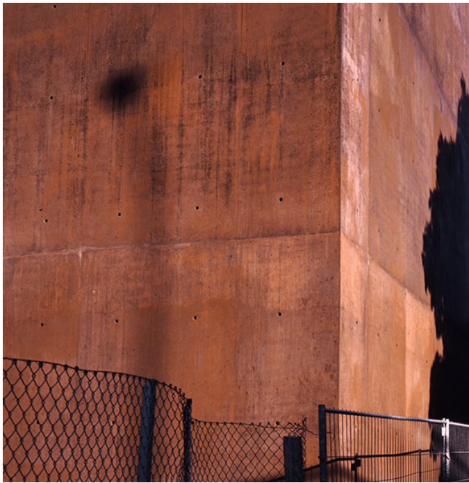
Poste d'aiguillage CFF, Zurich, 1996-99 Architectes: Gigon / Guyer
