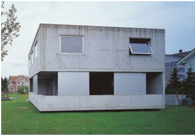
Maison Gantenbein, Grabs, 1995 Architecte: Peter Märkli
