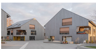
Fig. 69: Place centrale [PONT 12 architectes]
