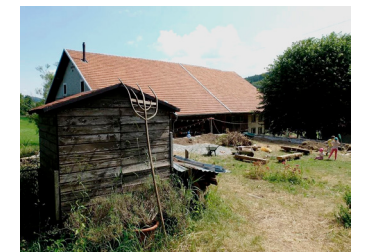
Fig. 55: Extérieur avant travaux [Les Coloriés]
