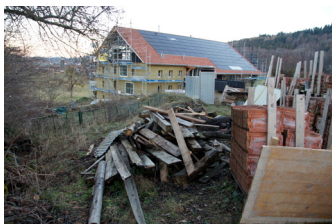
Fig. 42: Matériaux récupérés de la déconstruction [Allémann 2020]
