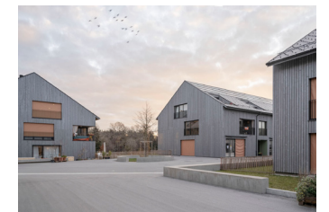
Fig. 59: Place centrale [PONT 12 architectes]
