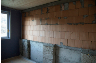
Fig. 41: Réhabilitation de la maçonnerie [Allémann 2020]
