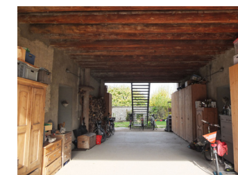
Fig. 20: Travées ouvertes [Allémann 2020]
