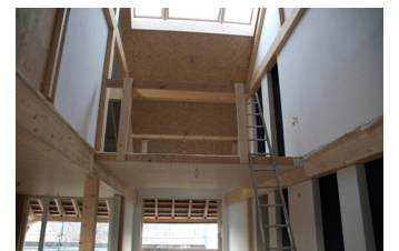
Fig. 43: Cage d'escaliers [Allémann 2020]
