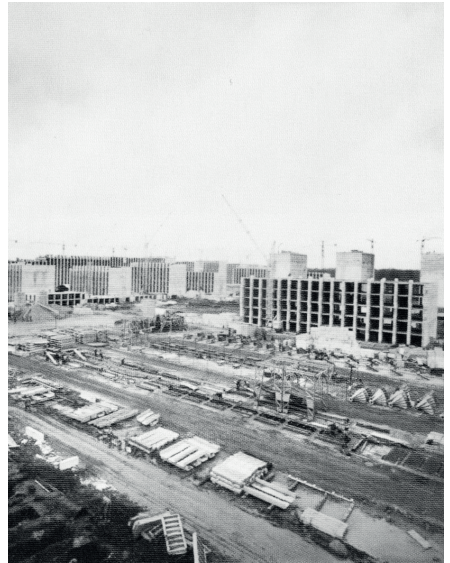
Meudon-la-Forêt Les éléments préfabriqués sont organisés le long des chemins de grue.
