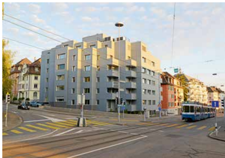
Les immeubles de la Hofwiesenstrasse avant rénovation (en haut) et après rénovation (en bas). © Viridén+Partner / Nina Mann
