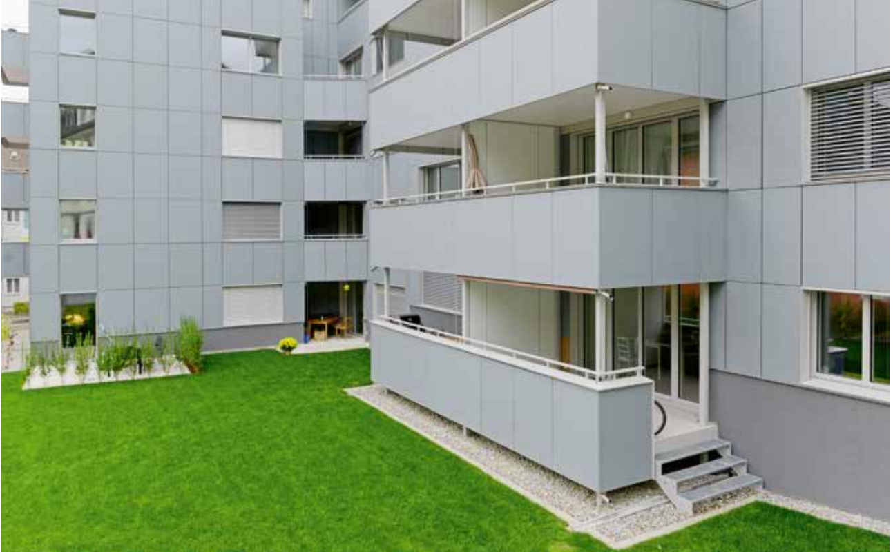
La cour intérieure, avec ses façades et balcons équipés de modules de verre actifs. © Viride'n+Partner / Nina Mann
