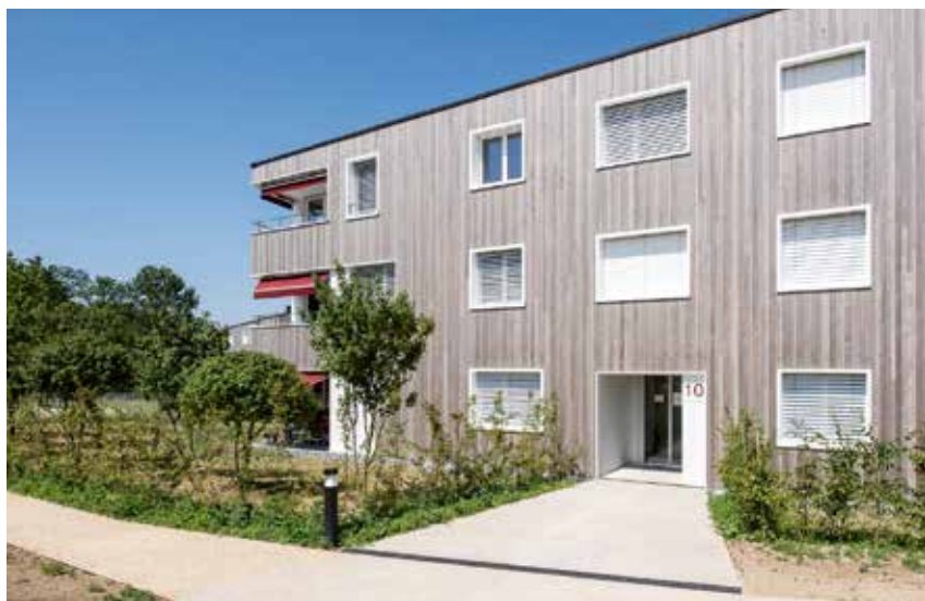
La SCHL privilégie la création de logements adaptés dans ses projets, comme ici à Cheseaux. ©SCHL
