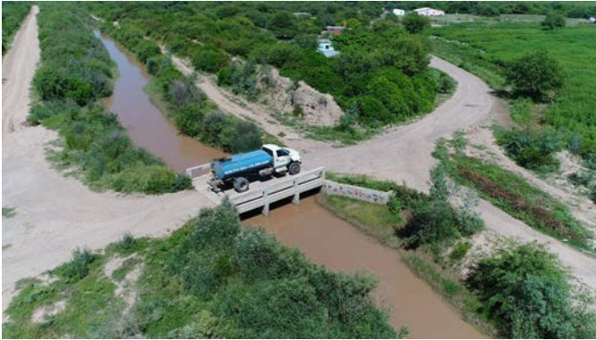
Fotografía 1: Proyecto: Puente vehicular en Colonia Dora, Santiago del Estero.
