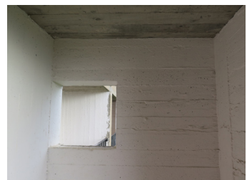
fig. 5: loggia d'une cellule du pavillon D
