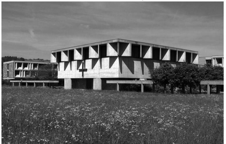
fig. 2: Vue de la façade Sud du couvent
