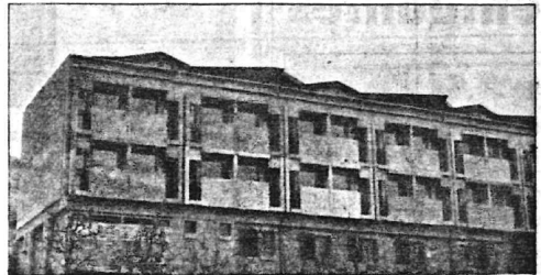
Un aspect de l'aile sud du couvent. — (Photo Scwery).
