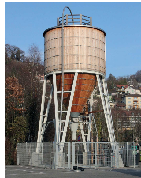
FIG.2 Silo à sel, Pully
