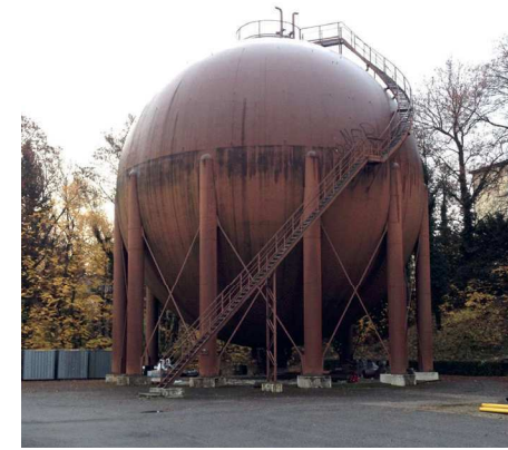
FIG.4 Silo à gaz, Lausanne
