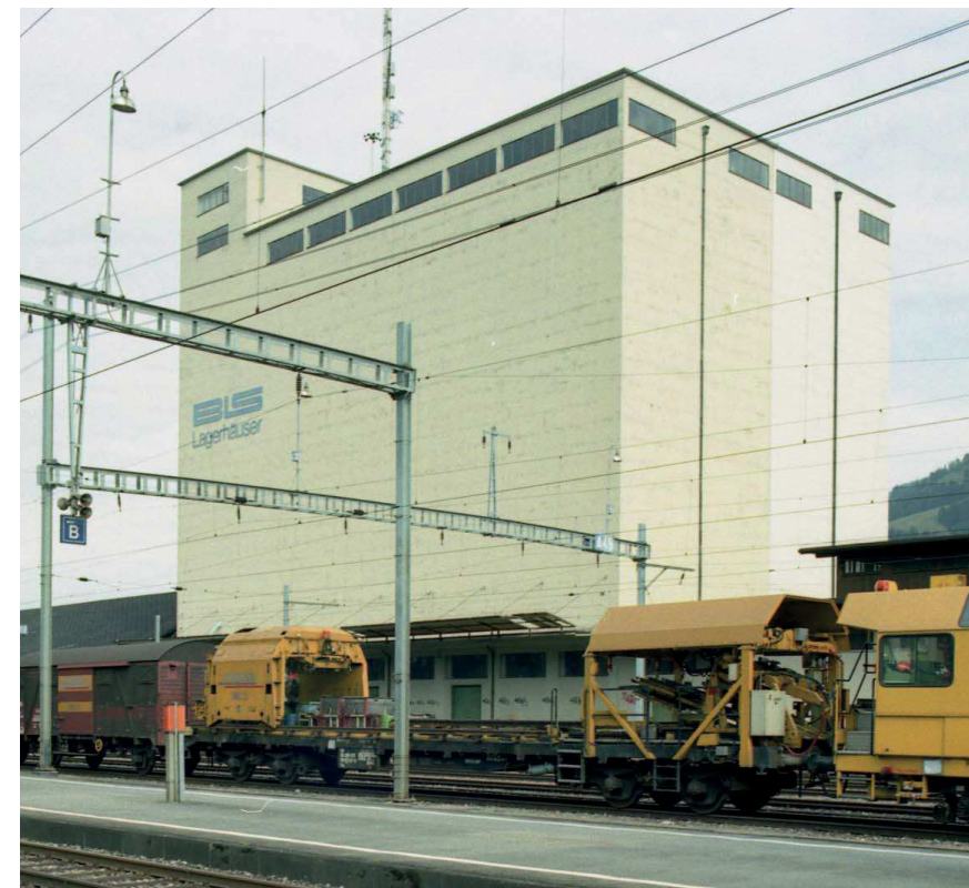
FIG.18 Silo fédéral à Frutigen, après agrandissement et avant démolition
