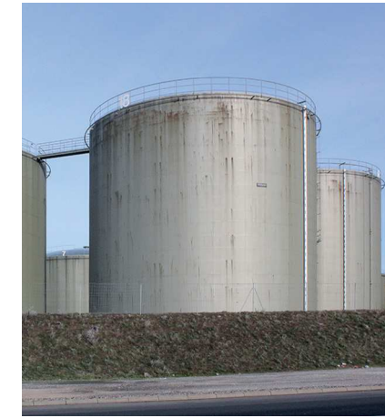
FIG.5 Silos pétroliers, Romont
