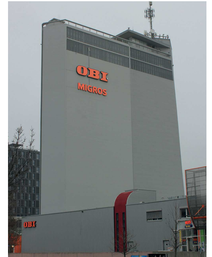
FIG.42 Vue de la façade est en 2018
