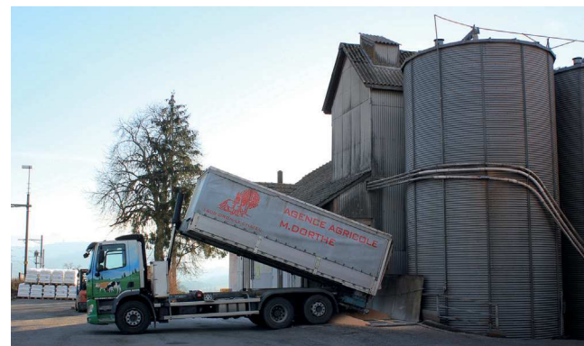
FIG.28 Conduits de répartition dans les cellules du silo ASS à Moudon
