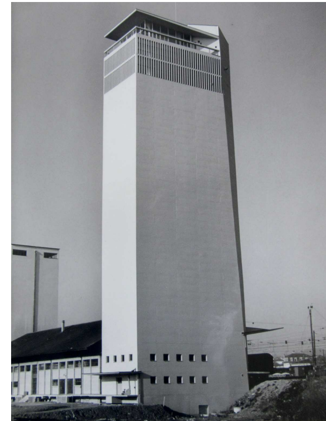
FIG.41 Vue de la façade est en 1959
