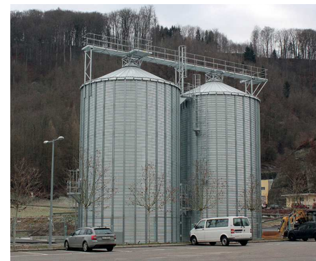
FIG.3 Silos à pellets de bois, Moudon
