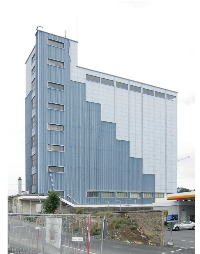
FIG.48 Vue de la façade sud en 2014
