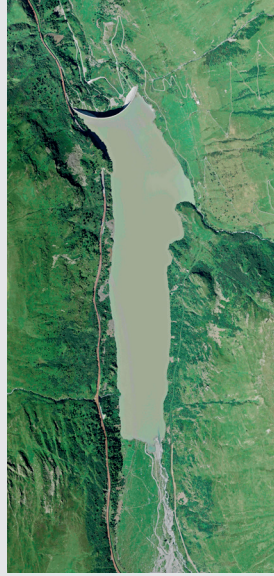
BARRAGE : Les Toules TYPE : barrage-voûte ANNEE : 1963
