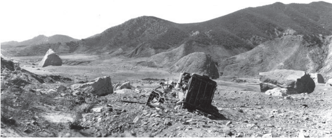
f.7 Ruines du barrage de Saint-Francis, Californie du sud, 1928. Blocs transportés durant la catastrophe.
