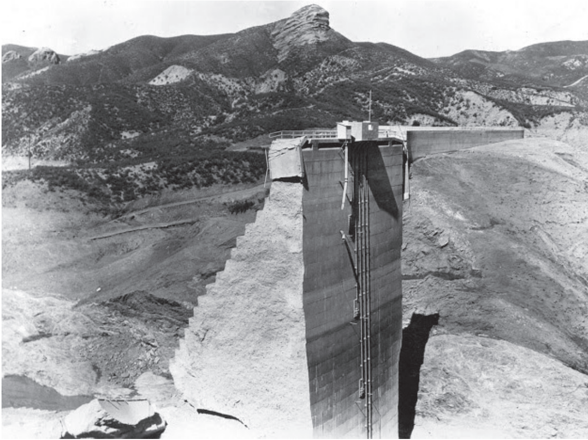
f.3 Ruines du barrage de Saint-Francis, Californie du sud, 1928. Certaines portions du barrage-poids sont restées en place, pilier solitaire.
