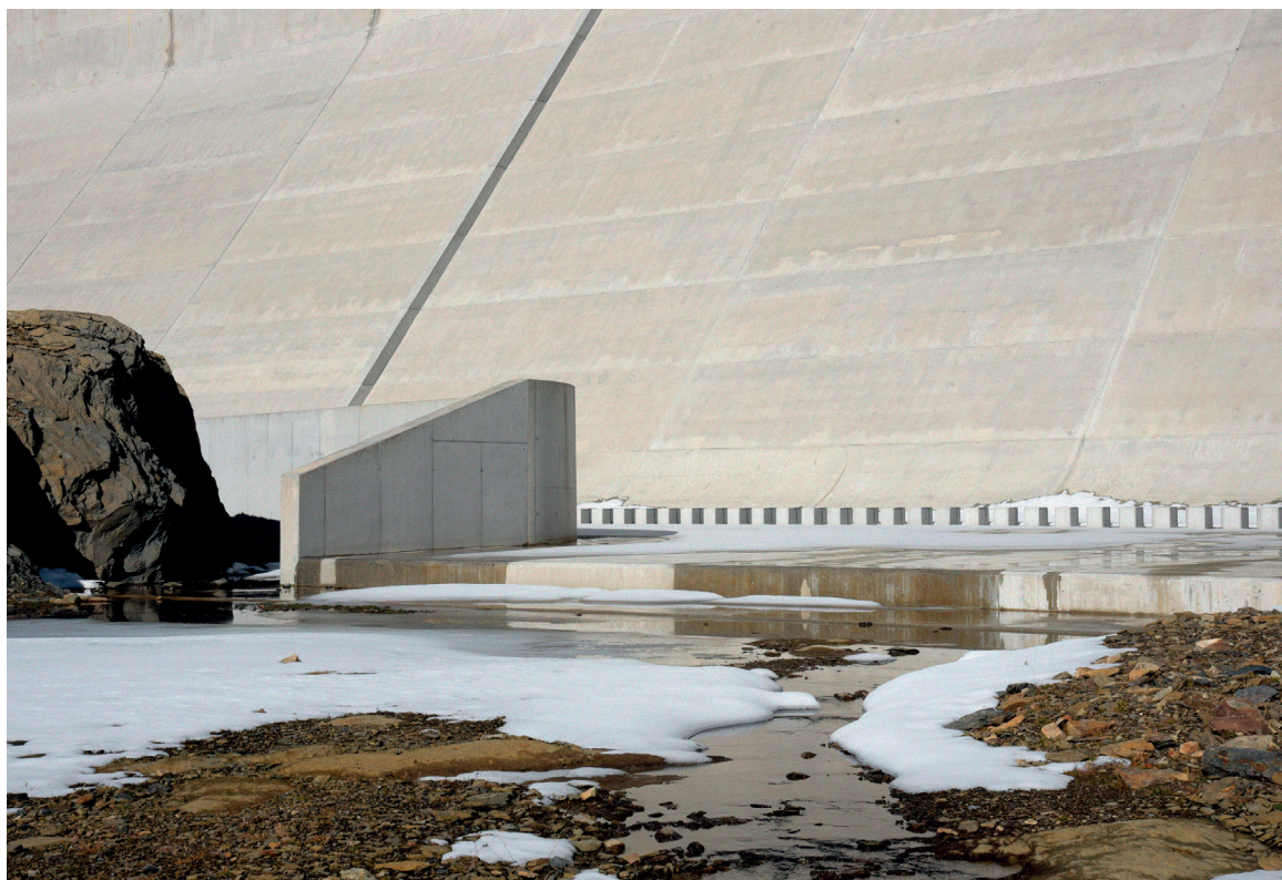
f.11 Barrage de Muttsee, Glaris. La photographie montre une partie de l'évacuateur de crue du barrage poids. Le mur lateral contourne une roche et brise la force de l'eau deversée.
