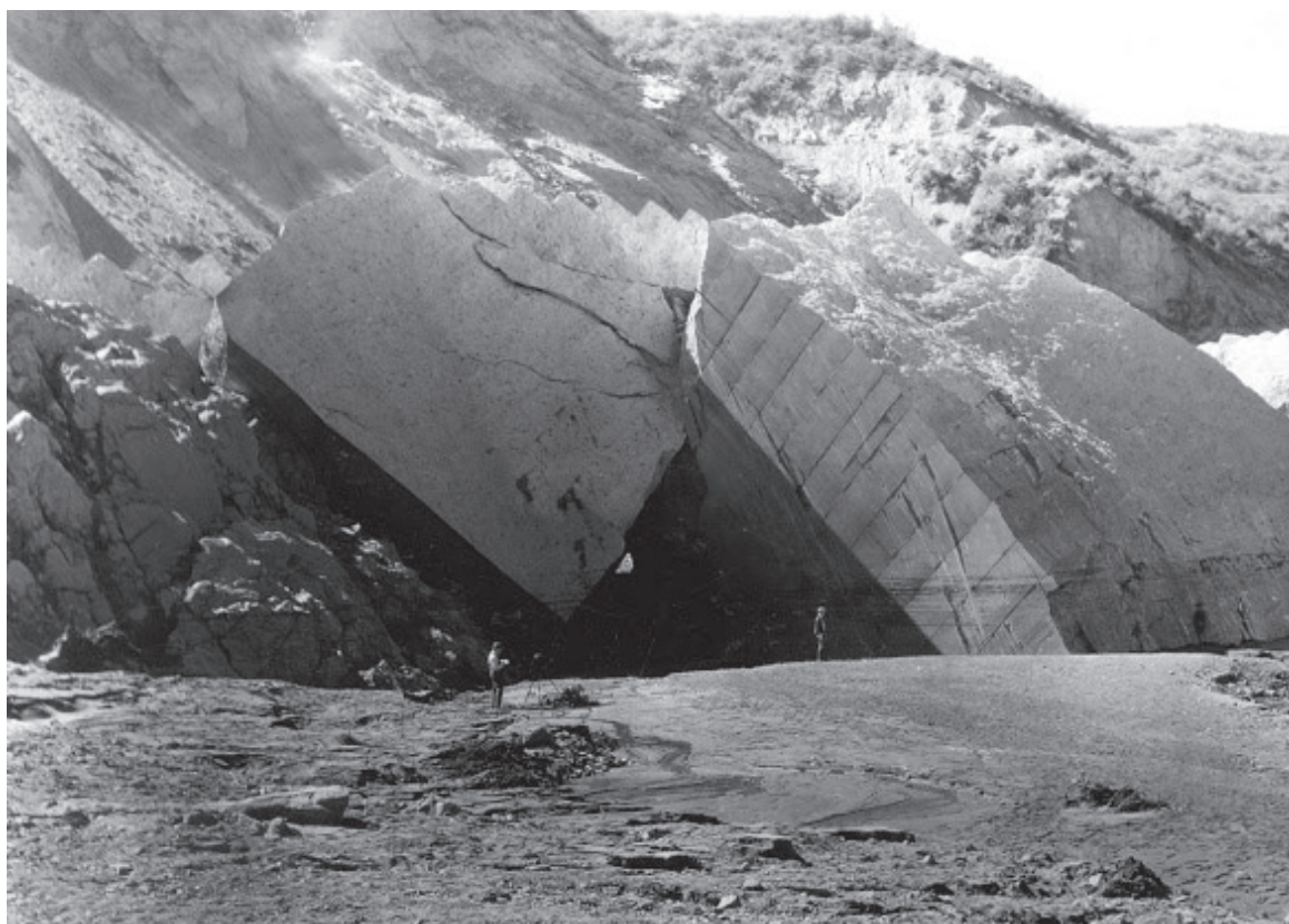
f.4 Ruines du barrage de Saint-Francis, Californie du sud, 1928. Fragments affaissés et transportés par les flots
