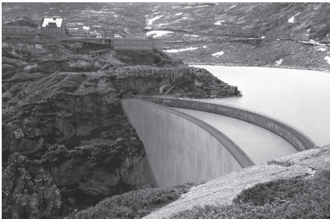
f.1 Photomontage du nouveau barrage de la Spitalamm. Chantier en cours. 2019-2025
