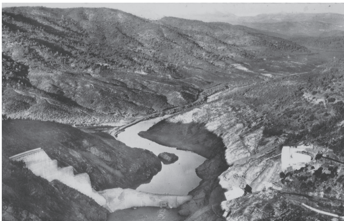
f.1 Ruines du barrage de Malpasset, 1962
