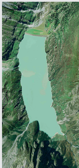
BARRAGE : Göschenalp TYPE : barrage en enrochement ANNEE : 1962
