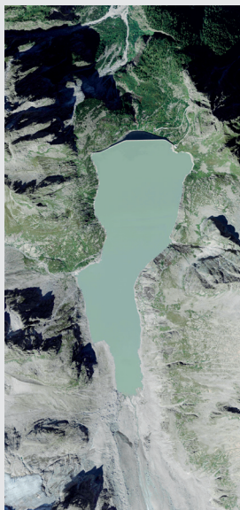
BARRAGE : Albigna TYPE : barrage-poids ANNEE : 1959
