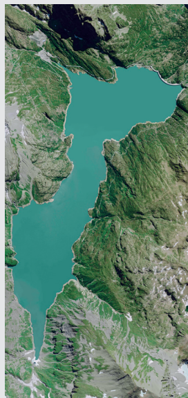
BARRAGE : Emosson TYPE : barrage-voûte ANNEE : 1974
