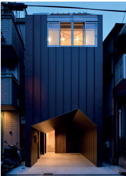
Une autre solution intelligente et très utilisée, est de rejoindre l'utile à l'agréable. Les normes urbaines obligent un emplacement pour les voitures sur chaque site. Pour ce faire, des Architectes construisent sur la totalité de la parcelle en creusant le rez-de-chaussée.
