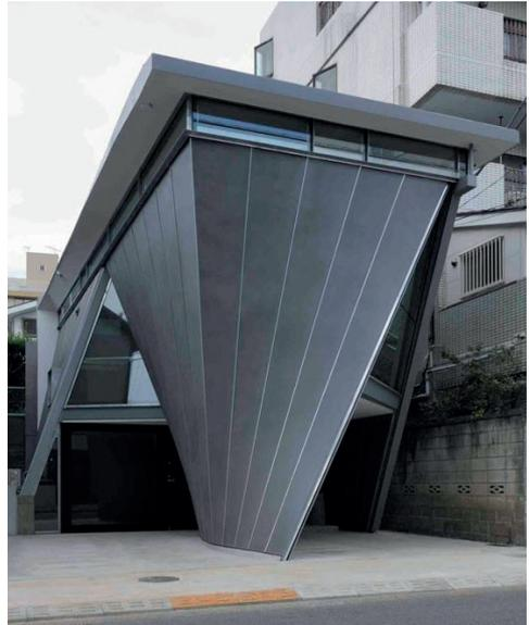
Même s'il est difficile de déterminer par où commence les murs, le fait qu'ils soient discontinus permet la création de fenêtres triangulaires généreuses dans les angles. Une pour éclairer le salon, l'autre pour éclairer la cuisine placée plus en retrait. Ce procédé ressemble à **W-Window House (p.12)** dont le placement des ouvertures est également stratégique, une pièce a sa source de lumière.
