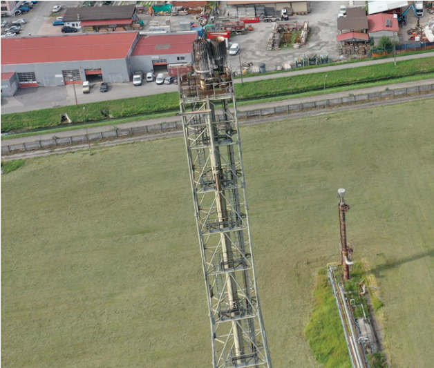
Fig. 22: (7) cheminée des unités de raffinage
