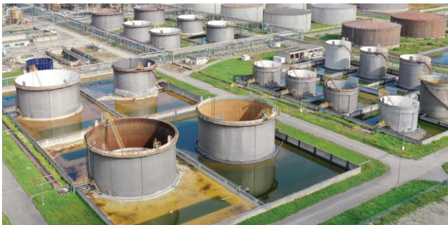
Fig. 10 : (1) réservoirs à toit flottant
