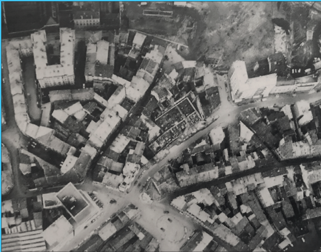
Photo aérienne du quartier de la Boucherie en travaux prise en 1964
