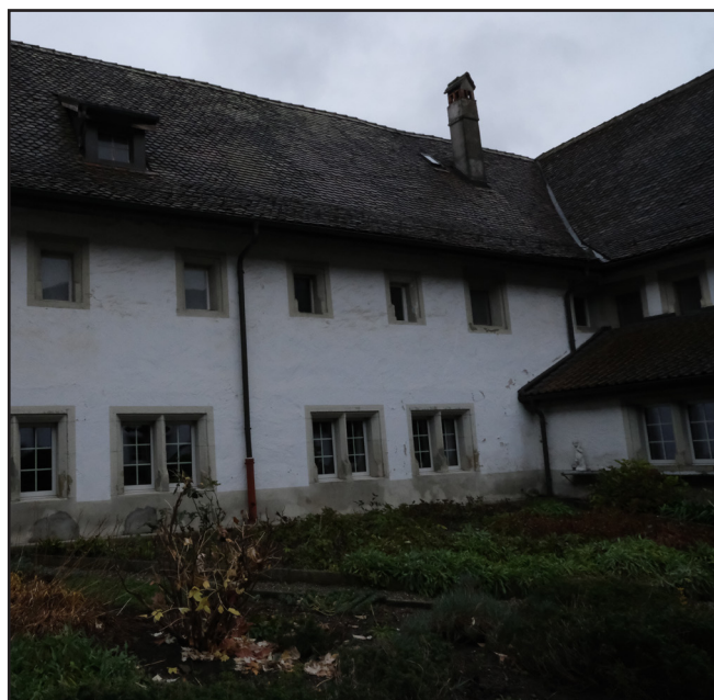
Les façades intérieures est et sud
