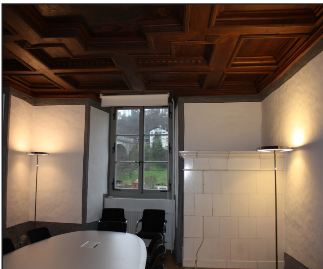
La salle de conférence de l'aile ouest avec le plafond en caisson et un ancien poêle
