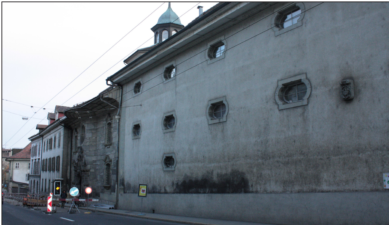
Les façades des différents bâtiments côtés rue. Le bâtiment neuf (à droite) possède que très peu d'ouvertures
