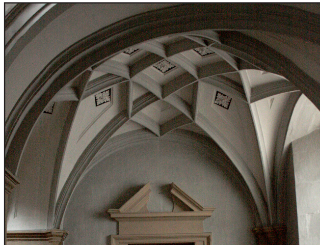
Une voûte gothique de l'église
