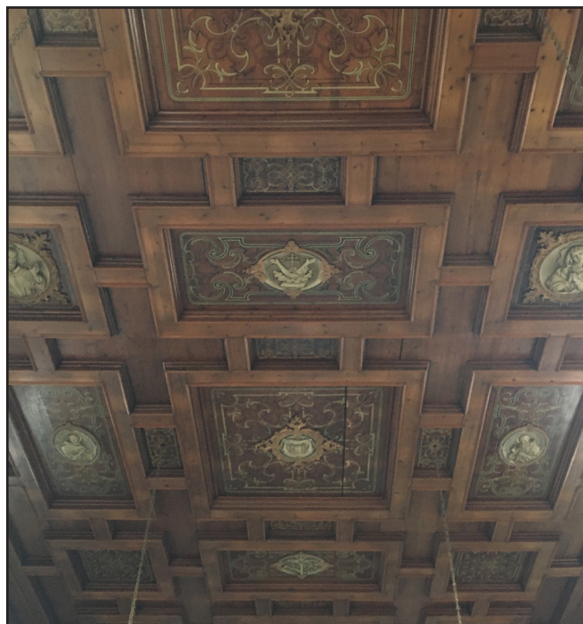
Plafond en caissons de l'église
