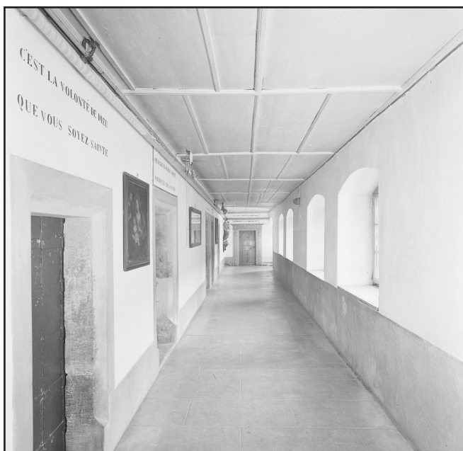
88 Le cloître quand il n'avait pas encore d'ouvertures zénithales. Photo prise entre 1938 et 1960. Fonds Jacques Thévoz © BCUF
