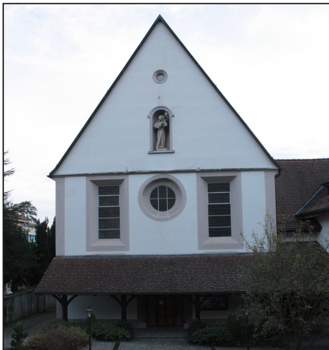
Façade ouest de l'église
