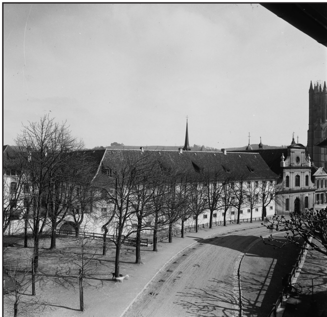
Vue d'ensemble avant le rehaussement de 1937. Fonds Prosper Macherel © BCUF
