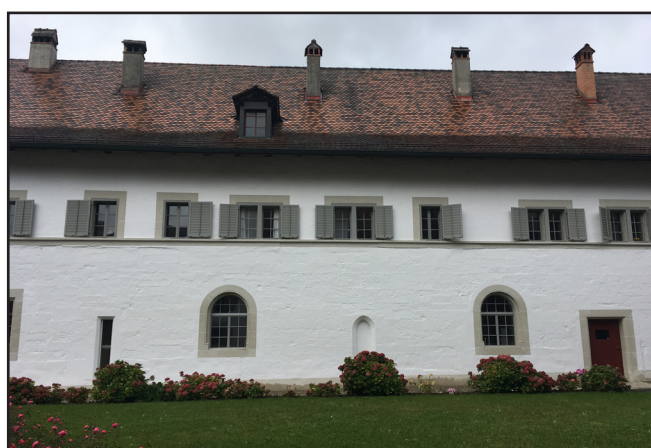
Façade est des bâtiments conventuels, les fenêtres bouchées restent visibles derrière le crépi
