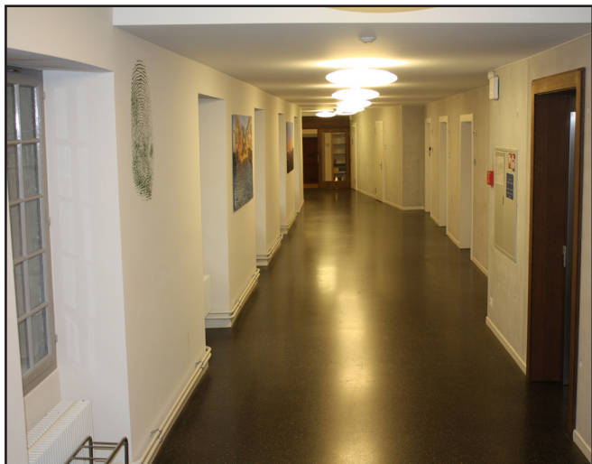
Avec l'introduction du mur en béton brut (à droite) le bâtiment a retrouvé la logique distributive du couvent
