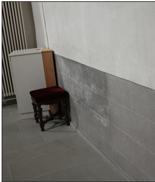
L'appareillage irrégulier en molasse est recouvert de crépi et un appareillage régulier est peint par dessus
