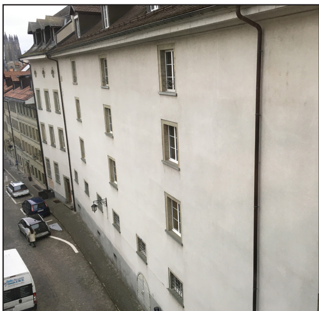
La façade nord de l'aile sud côté rue des Alpes
