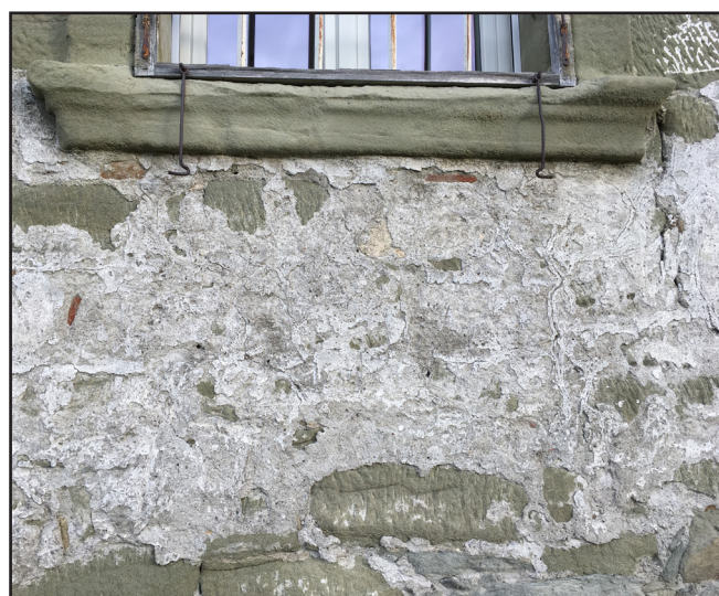
Le badigeon se décolle à certains endroits et laisse apparaître la molasse
