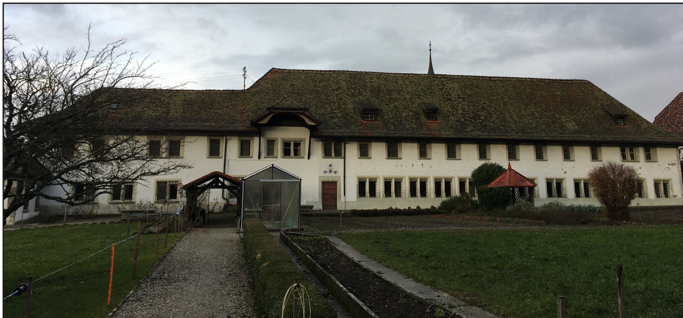
La façade sud
