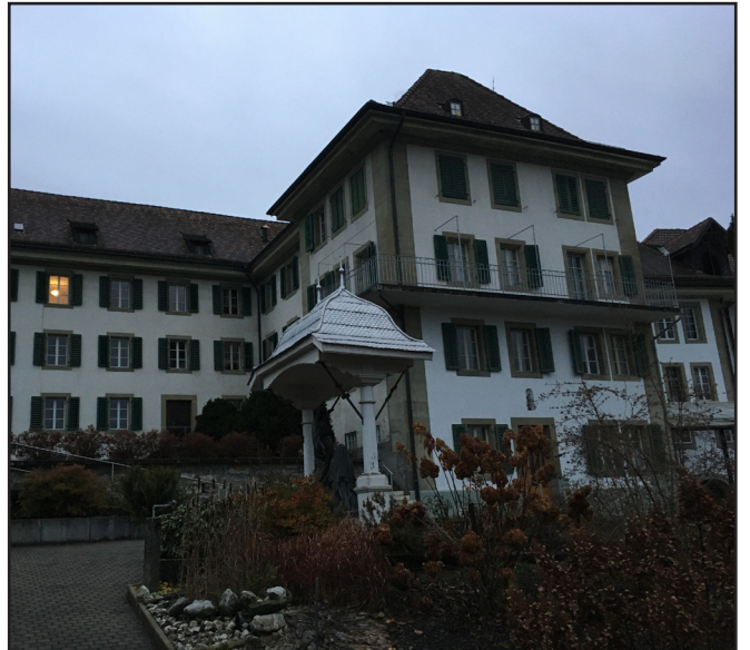
La façade côté jardin du «bâtiment neuf»
