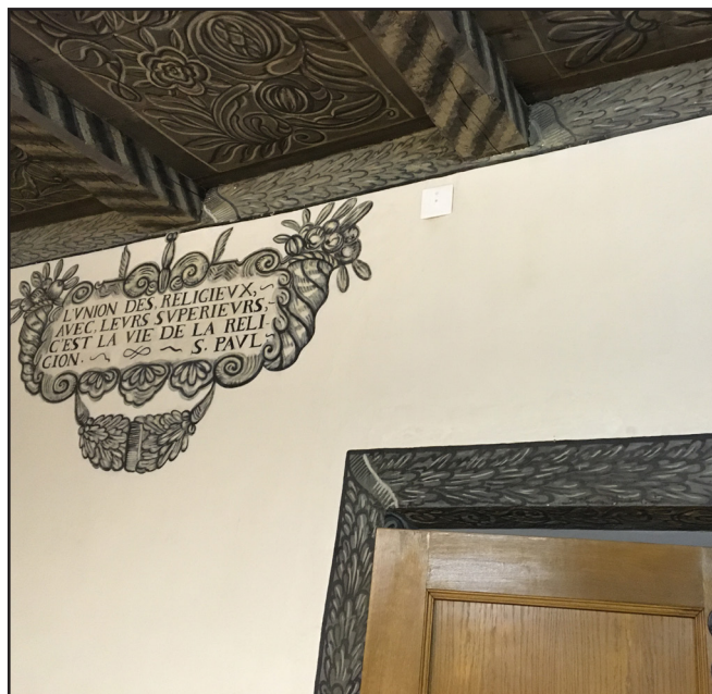
La poutraison du plafond de la salle de communauté
