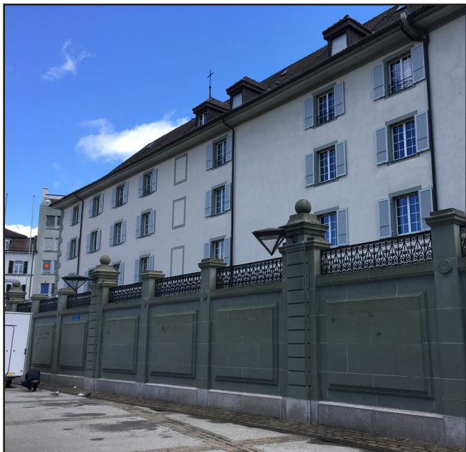
La façade ouest avec le mur aveugle côté place Georges-Python
