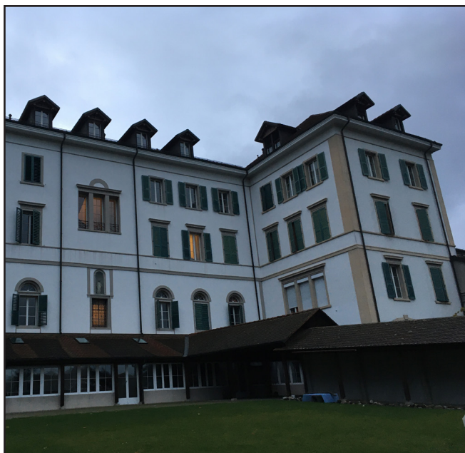
Façade côté jardin de l'ancien pensionnat
