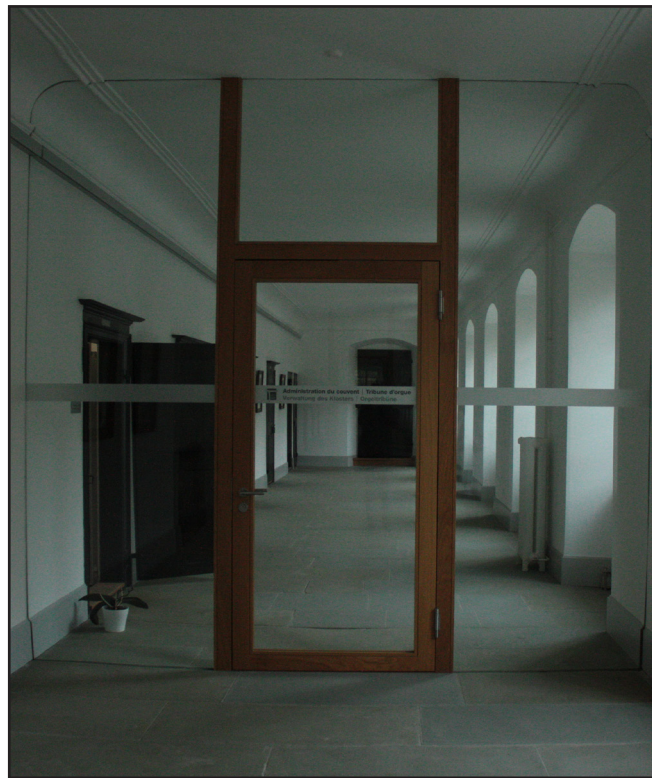
Sol en dallage de molasse dans le couloir du premier étage remis à nu lors de la dernière restauration
