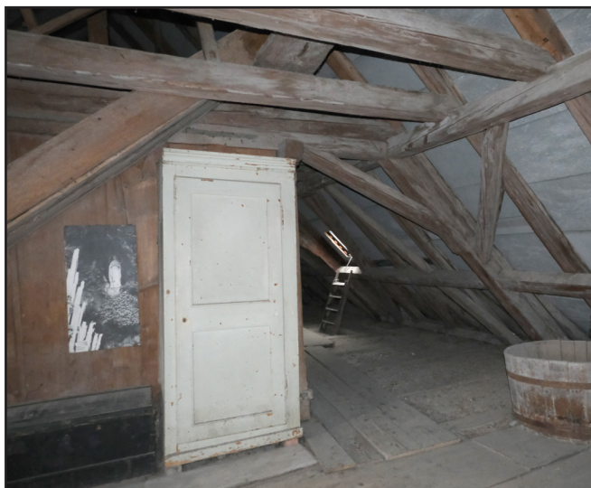
La grande charpente du toit
