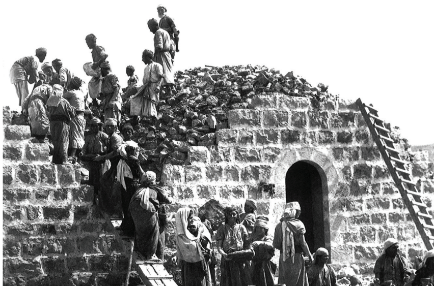
Ill 23 : Chantier d'une maison traditionnelle palestinienne. ©www.riswaq.org / Maston collection
