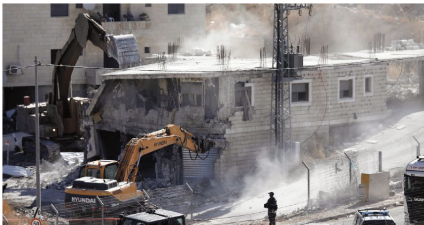
Ill 33 : Démolition. © https://www.lenouvelliste.ch/articles/monde/demolition-controversee
