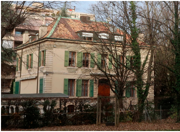
Fig.52 «Maison du Maître des Vollandes» à la route de Frontenex
