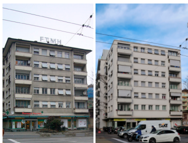
Fig.15 Mimétisme: Avenue Wendt 12 avant et après la surélévation - Aebi et Vincent Architectes
