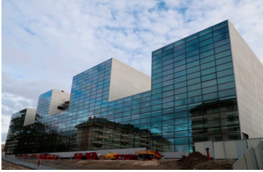
Fig.51 La «Nouvelle Comédie» en chantier depuis la rue Viollier
