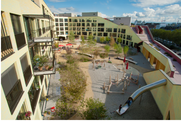
Fig.21 Cour intérieure de Kalkbreite - Genossenschaft Kalkbreite
