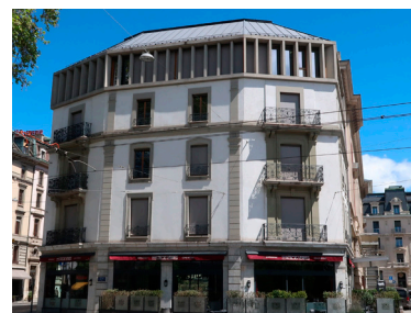
Fig.19 Exemple de combinaison sur un bâtiment du XIX e s.: place du Cirque
