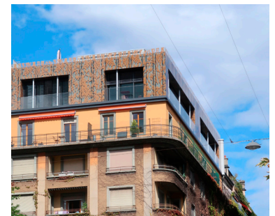
Fig.14 Rupture: rue de l'Athénée 22
