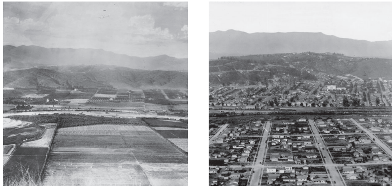
Los Angeles River depuis Elysian Park, en 1900 à gauche, en 1926 à droite
