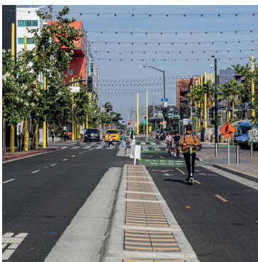
Piste cyclable séparée par un terre-plein à Santa Monica
