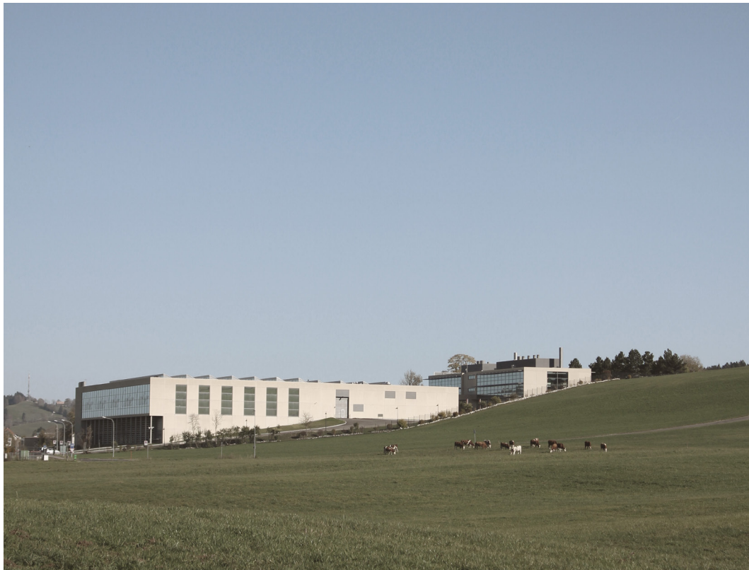
Usine Cartier, Le Crêt-du-Loche Photo de l'auteur (2019)
