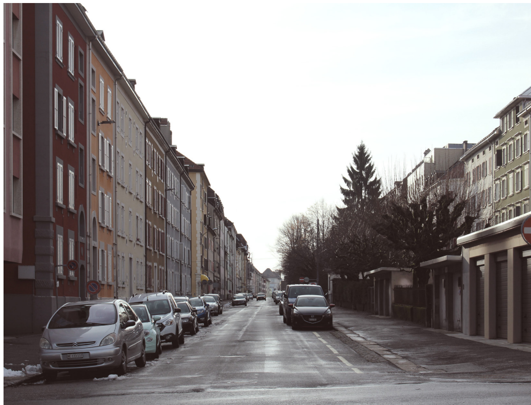
Rue typique de l'urbanisme horloger, Rue Jardinière, La-Chaux-de-Fonds (CH) Photo de l'auteur (2019)
