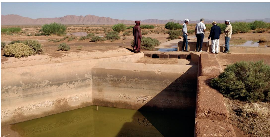
Système de filtration d'eau pluviale inopérant vers Bouarfa
