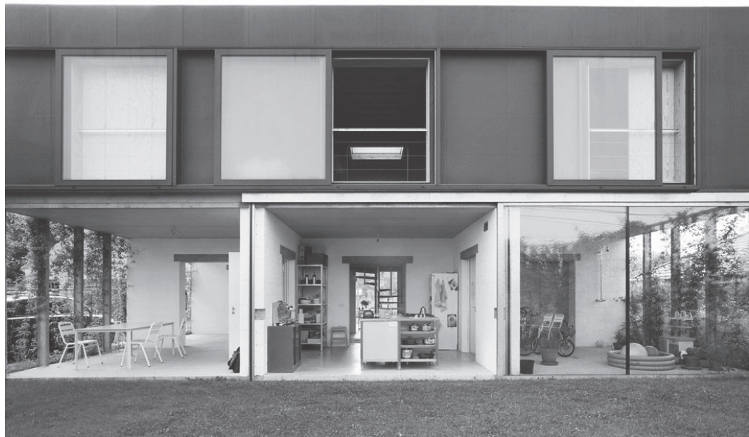
Fig.29 Office, Villa Buggenhout, 2007-2012. Vue sur la porte vitrée coulissante qui ouvre et ferme simultanément.
