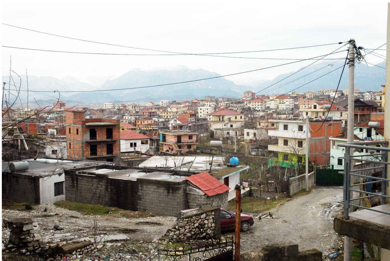
Illustration 5.8 : Vue typique du tissu bâti « informel » qui s'est développé de manière rapide et désordonnée à la fin des années 1990 et au début des années 2000 surtout dans les banlieues nord, ici à Kamzë (photo A. Jarne, 2010)
