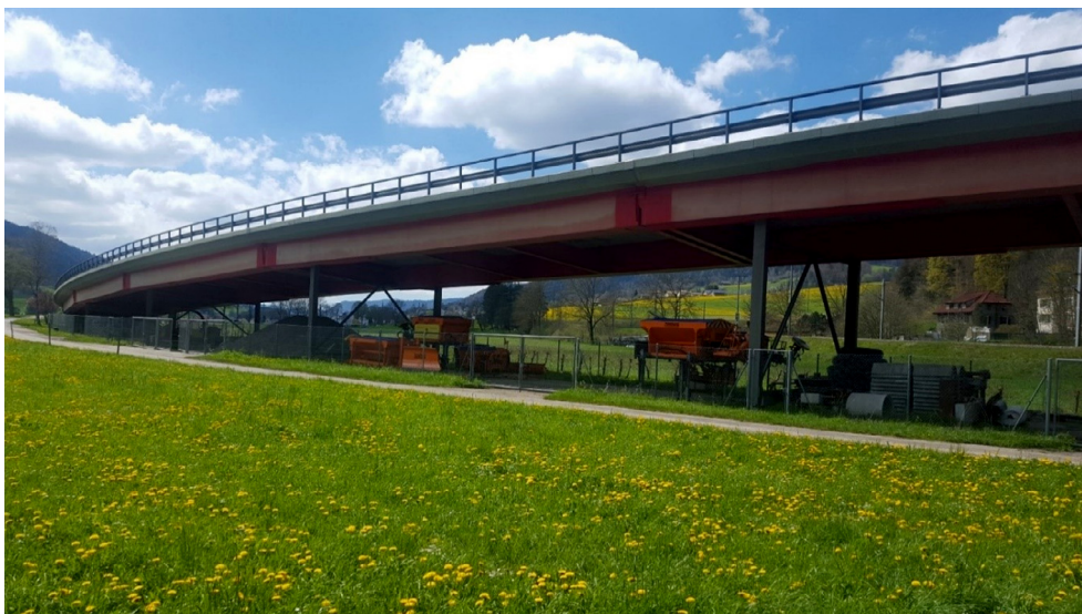
Fig. 5. Crêt De l'Anneau: the investigated steel-concrete composite viaduct.
