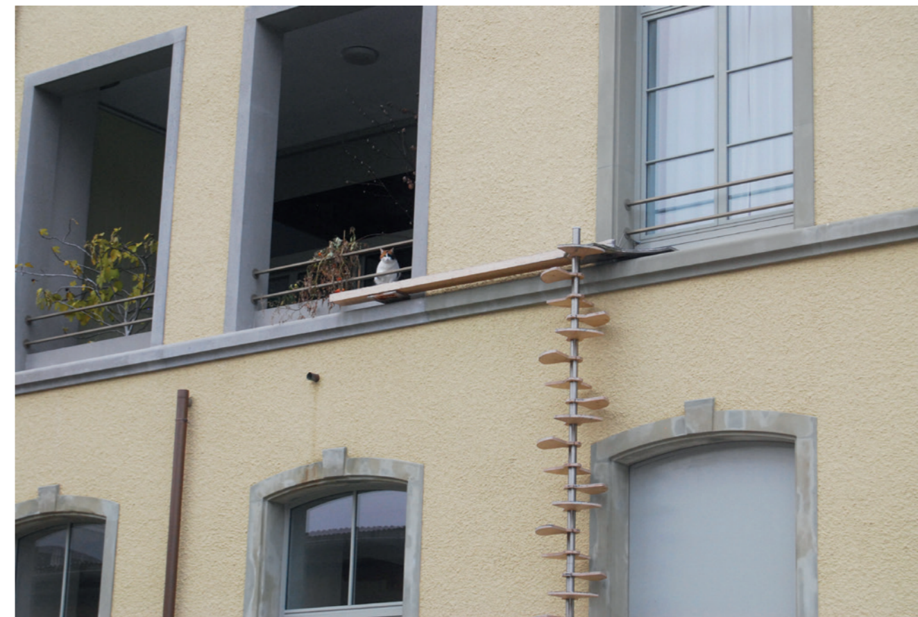
Loggias, partie rénovée (photo personnelle)
