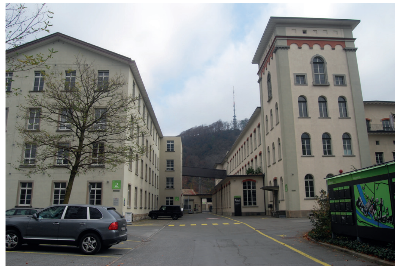
Spinnerei jenny, Ziegelbrücke Stutz Bolt Partner Architekten AG (photo personnelle)
