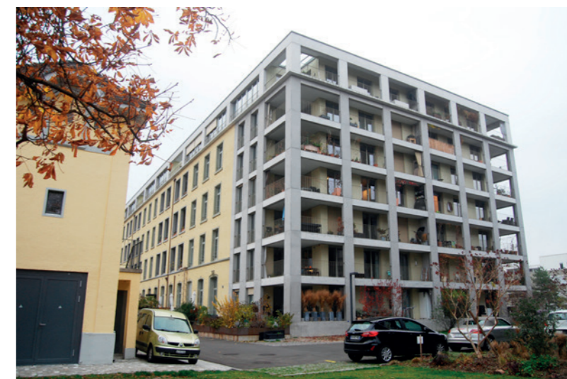
Vue de l'extension (photo personnelle)
