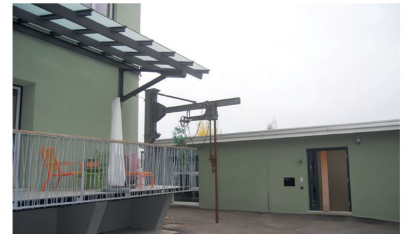
Balcon, ancien quai de déchargement (photo personnelle)
