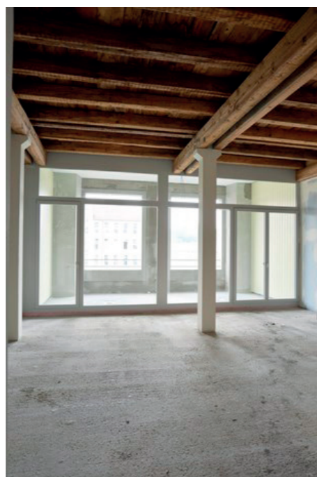
Photo de chantier ( http://www.spinnerei-drei.ch )
