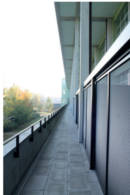
Coursive extérieure (photo personnelle)
