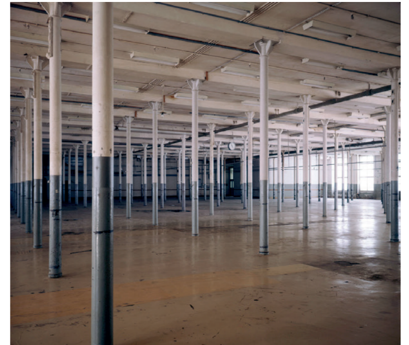
Espace avant la reconversion ( http://www.stutzbolt.ch )
