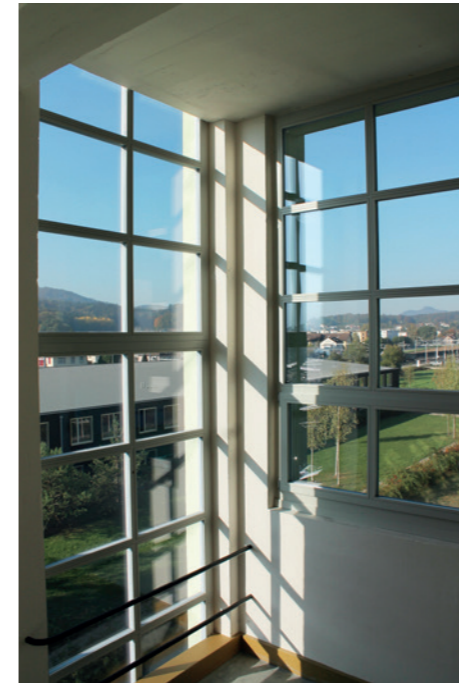
Cage d'escalier d'origine (1) (photo personnelle)
