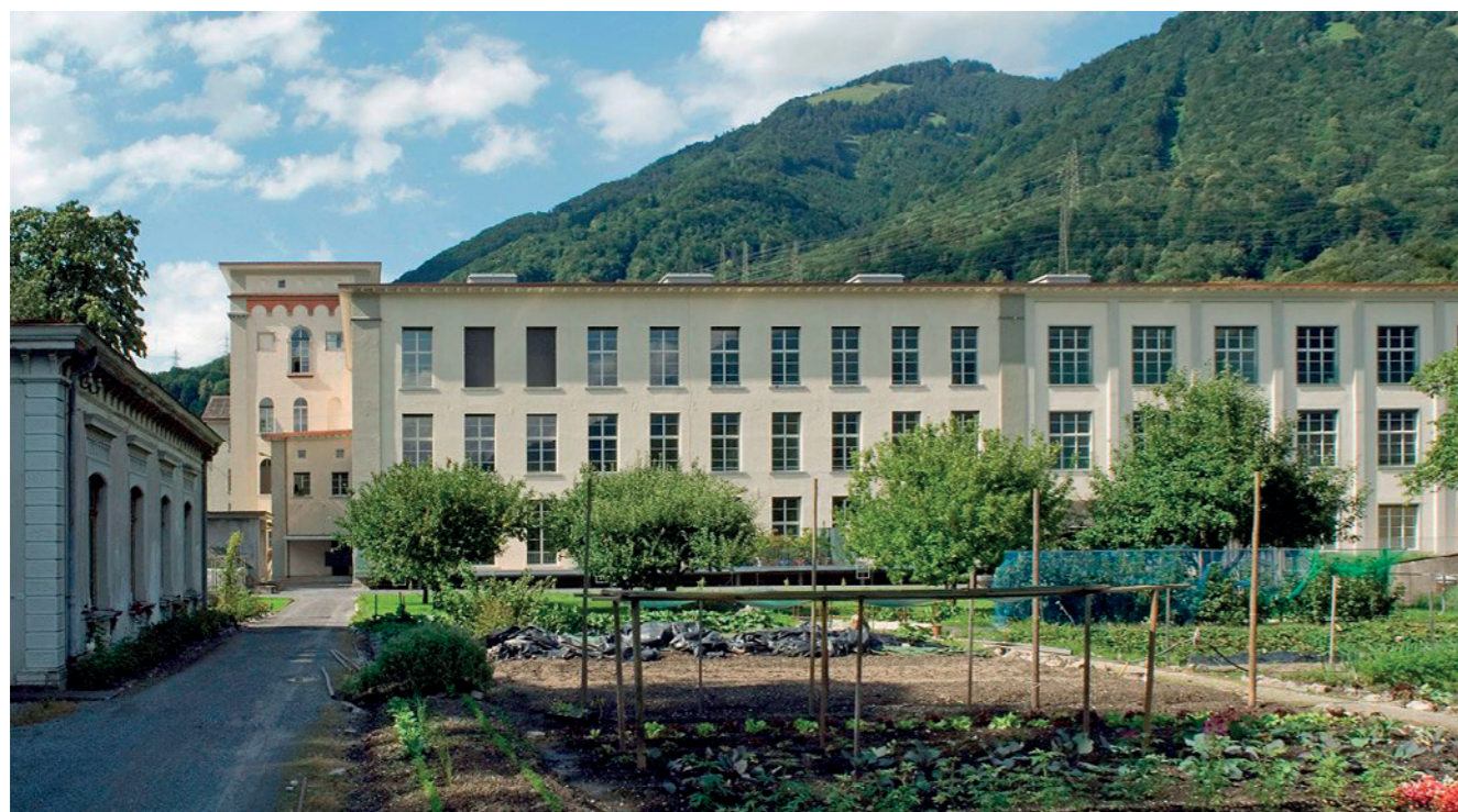
Spinnerei jenny, Ziegelbrücke Stutz Bolt Partner Architekten AG ( http://www.stutzbolt.ch )
