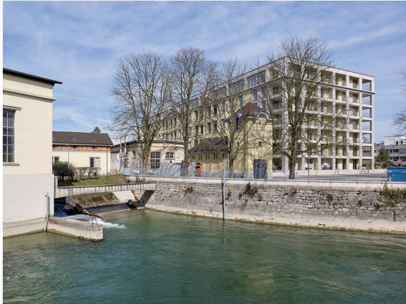
Spinnerei III, Windisch Adrian Streich Architekten AG ( http://www.adrianstreich.ch )
