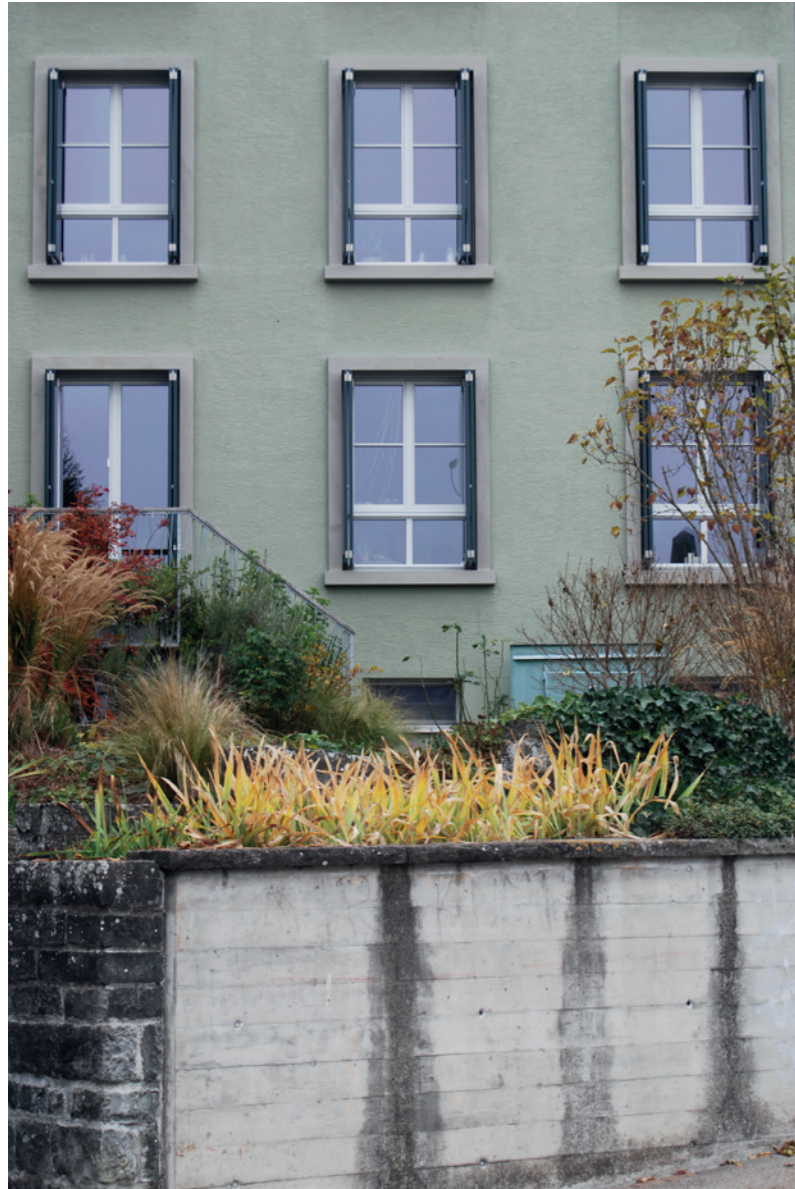
Façade Sud premier bâtiment (photo personnelle)
