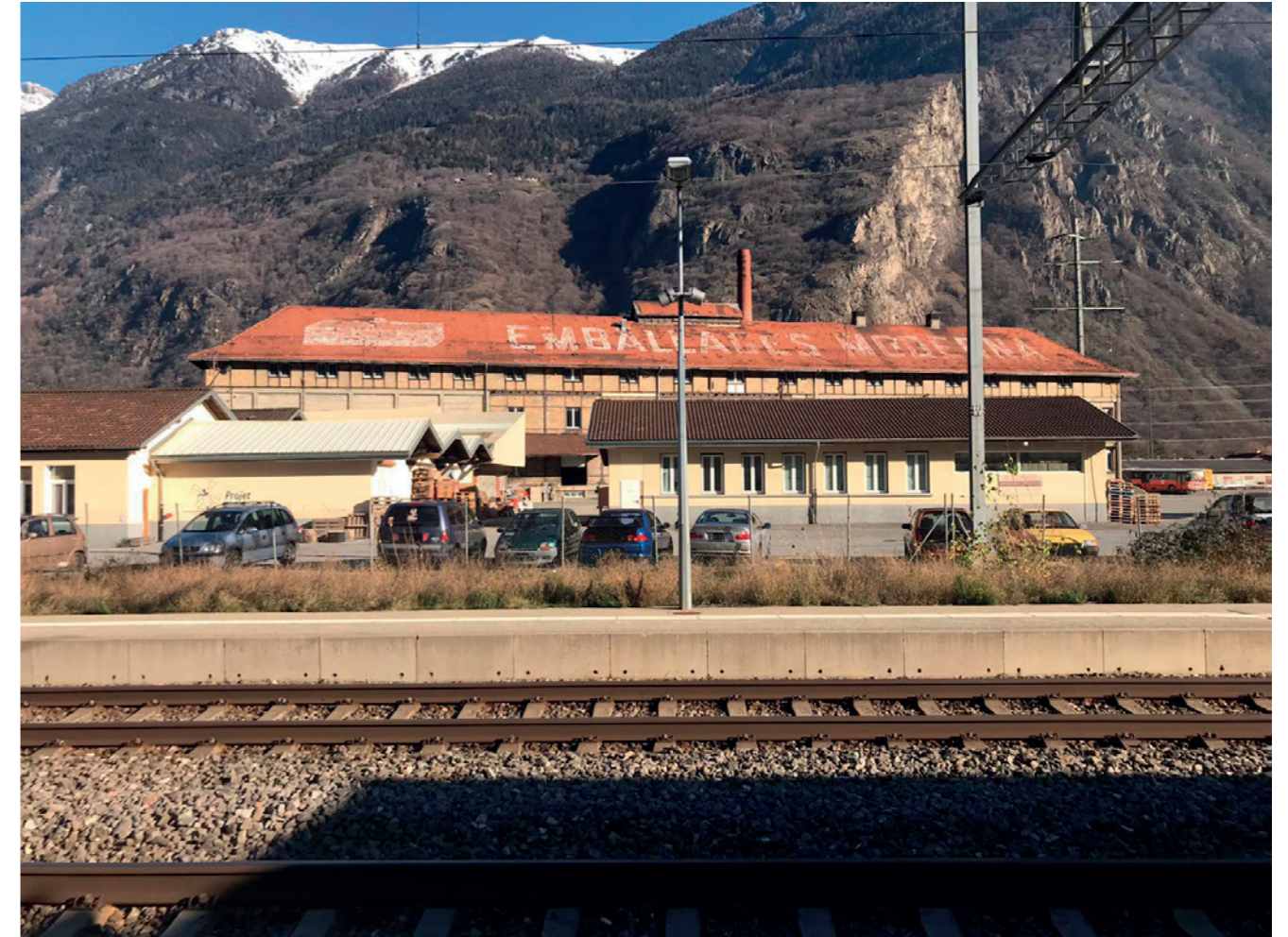
Vue de l'usine depuis la gare (photo personnelle)
