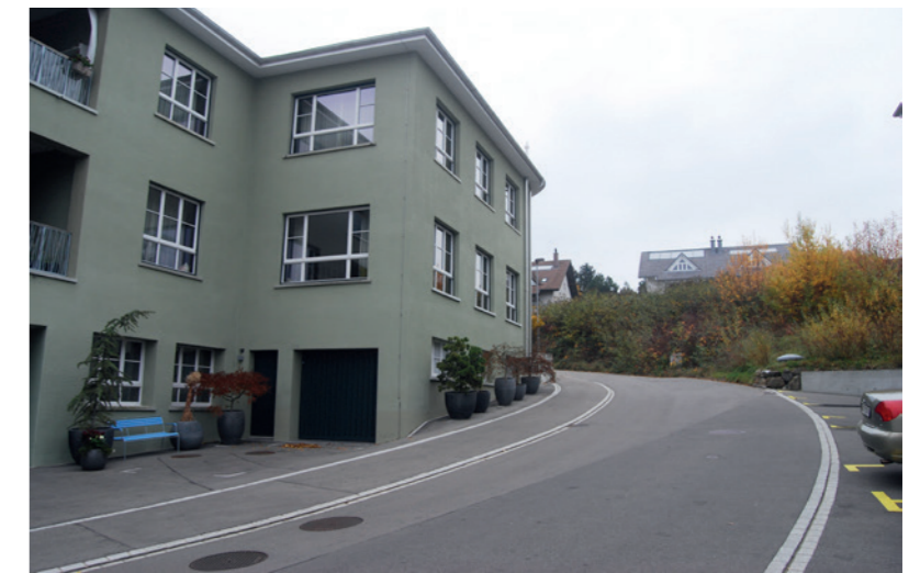
Place minérale et route (photo personnelle)
