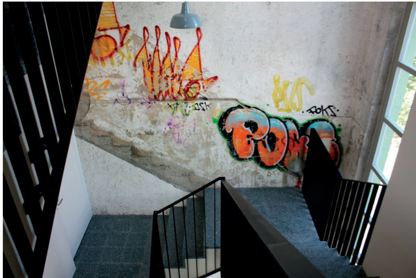
Cage d'escalier Ouest ( https://www.bosshard-farben.ch )
