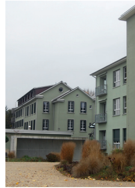
Balcons Ouest (photo personnelle)
