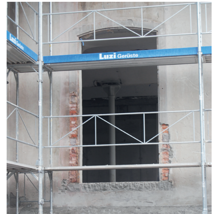
Chantier de la reconversion de la Textilfabrik de Mels par Burkhalter Sumi Architectes (Photo personnelle)
