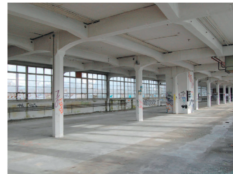
Intérieure de l'usine avant la reconversion ( http://www.adrianstreich.ch )
