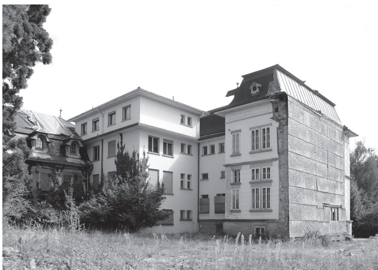
Façade nord actuelle
