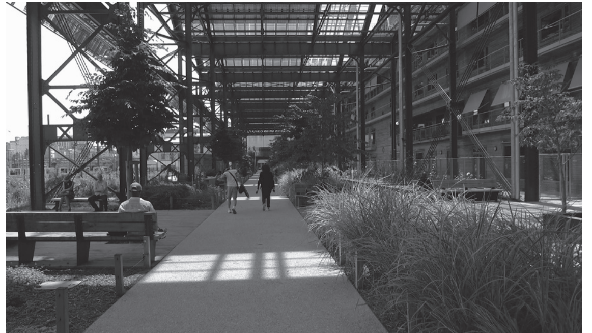
Halle Pajol de l'ancien pôle ferroviaire SNCF des années 20, désormais réhabilité en Rosa Luxemburg Garden par l'équipe de In Situ architectes paysagistes, Paris, 2014
