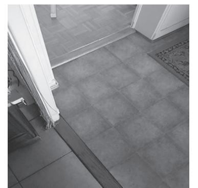
seuils massifs en bois
