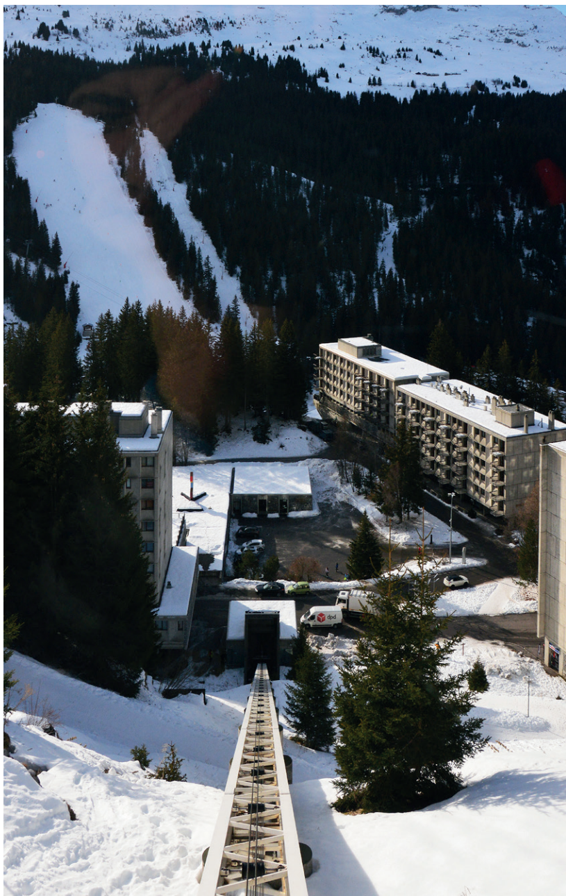
00:00 Gare de l'ascenseur incliné n°1 - Flaine Forêt
