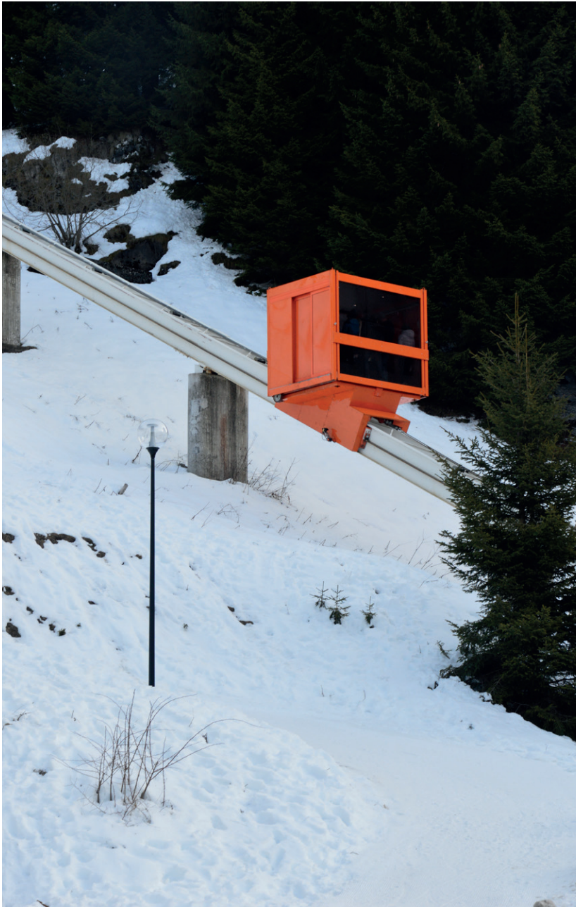
Ascenseur incliné n°1
