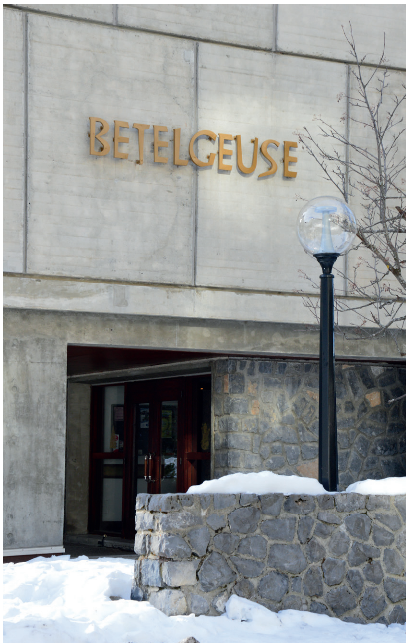
Entrée nord de la Résidence Bételgeuse
