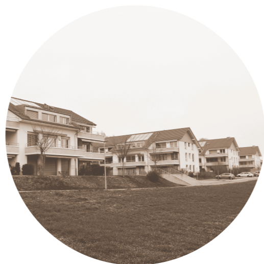
Salavaux (VD) Immeuble construit 4x Emplacement n°2
