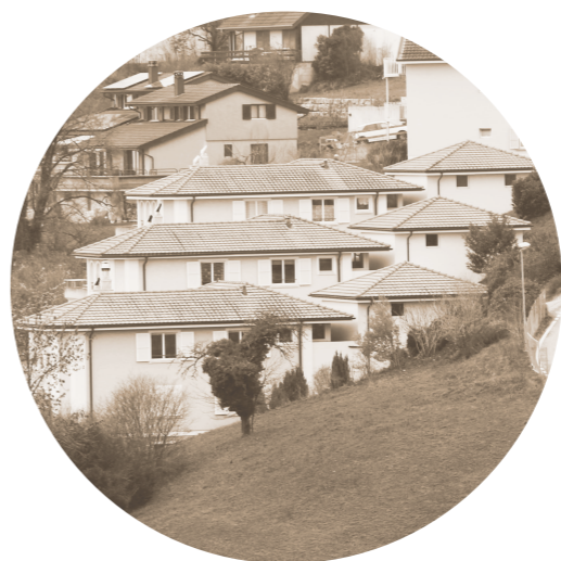
Sauges (NE) Villa à plusieurs logements construite 3x Emplacement n°4
