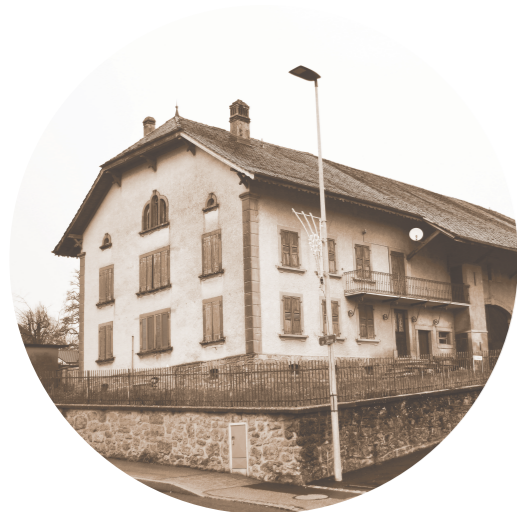
Partie d'habitation du bâtiment principal du site de Saint-Aubin (FR)
