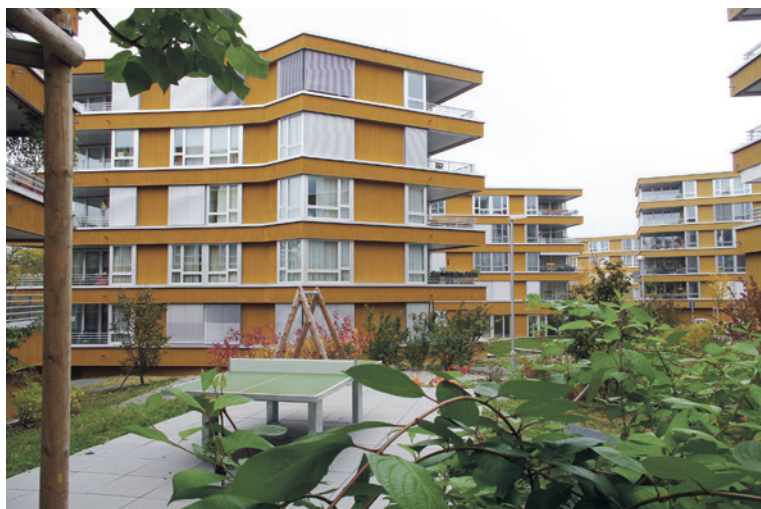
Fig. 95 Façades: tons ocre
