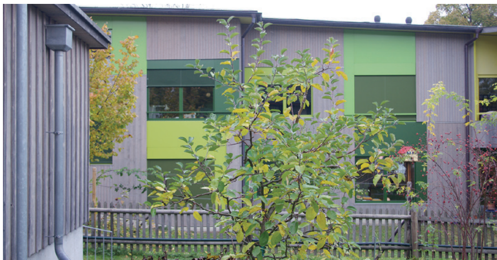
Fig. 72 vue frontale de la façade, côté maisons rurales
