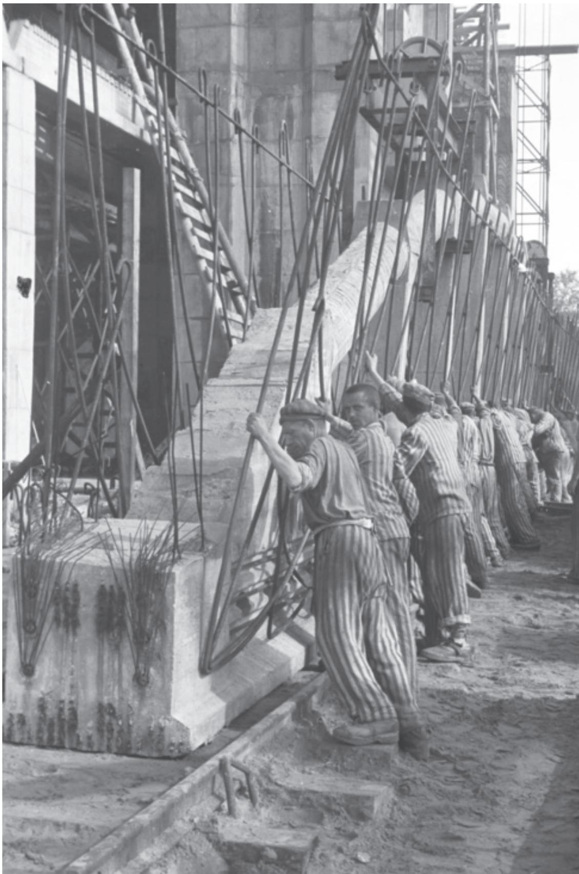
technique présentait l'avantage d'être rapide à réaliser, mais empêchait tout chargement ultérieur sur le bunker construit. On retrouve ces pieux pour les bunkers de Brest, Keroman III à Lorient et Bordeaux.
