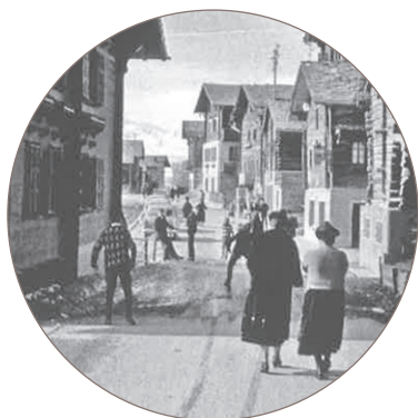
vue du village de Saint-Martin ©Saint-Martin au XX e siècle
