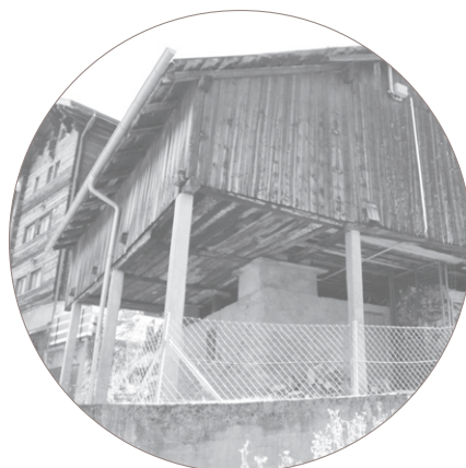
grange sur piliers en béton
