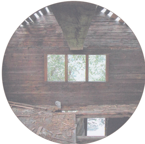
interieur d'une habitation avant rénovation, Ossona ©Ossona, 10 de réhabilitation
