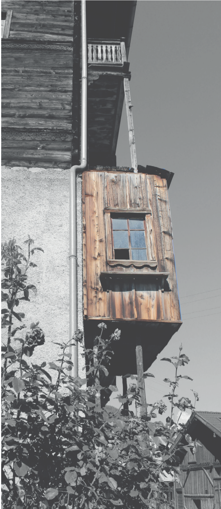
Aménagement d'un balcon en nouvelle pièce
