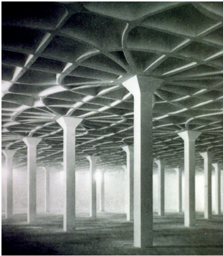
Fig. 19 : Usine de laine Gatti construite par Pier Luigi Nervi en 1951
