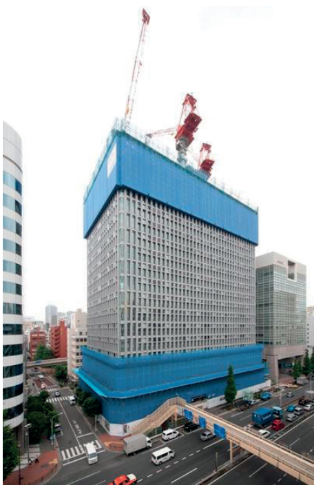
Fig. 16 : Quartier général de Shimizu Corporation réalisé avec un système de construction automatisé
