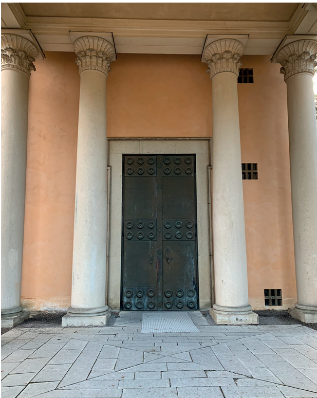
45. Porte d'entrée de la chapelle
