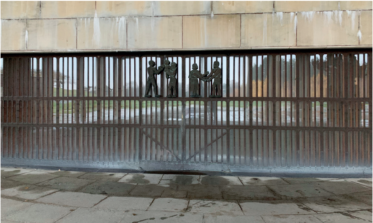
80. Porte d'entrée de la Chapelle Sainte Croix
