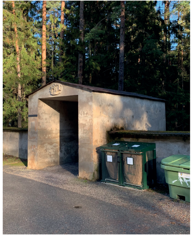
62. Le portique d'entrée de la Chapelle des Bois
