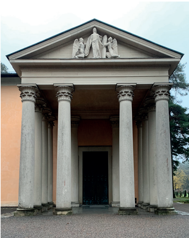
49. Fronton du portique
