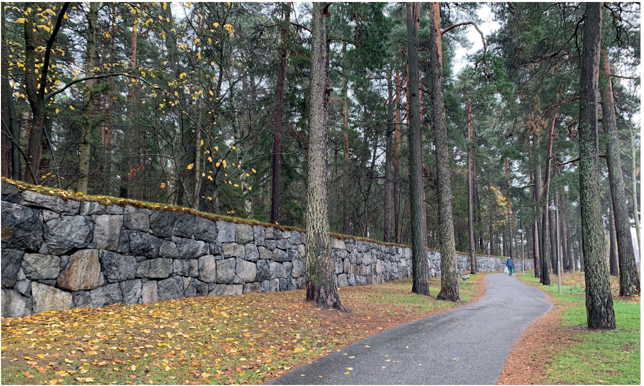
2. Murs d'enceinte, flanc ouest
