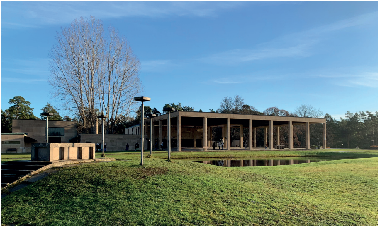
76. Le catafalque, l'étang et le portique monumental
