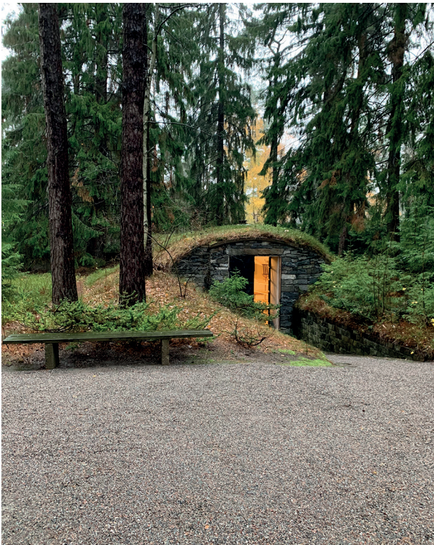
66. La salle mortuaire de la Chapelle des Bois
