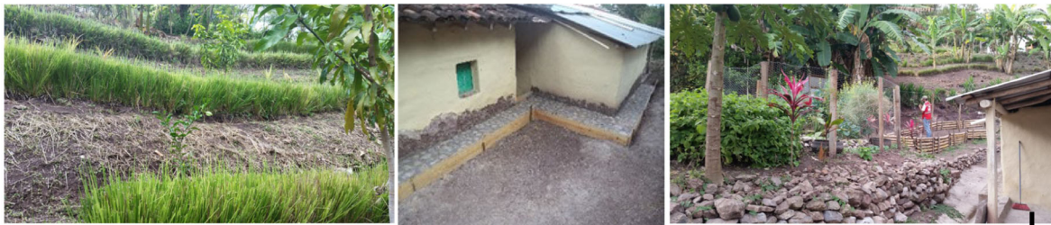
*De izquierda a derecha, imagen 1. Barreras vivas con vetiver, imagen 2. Drenaje con acera, imagen 3. Muro con piedras y huerto medicinal
