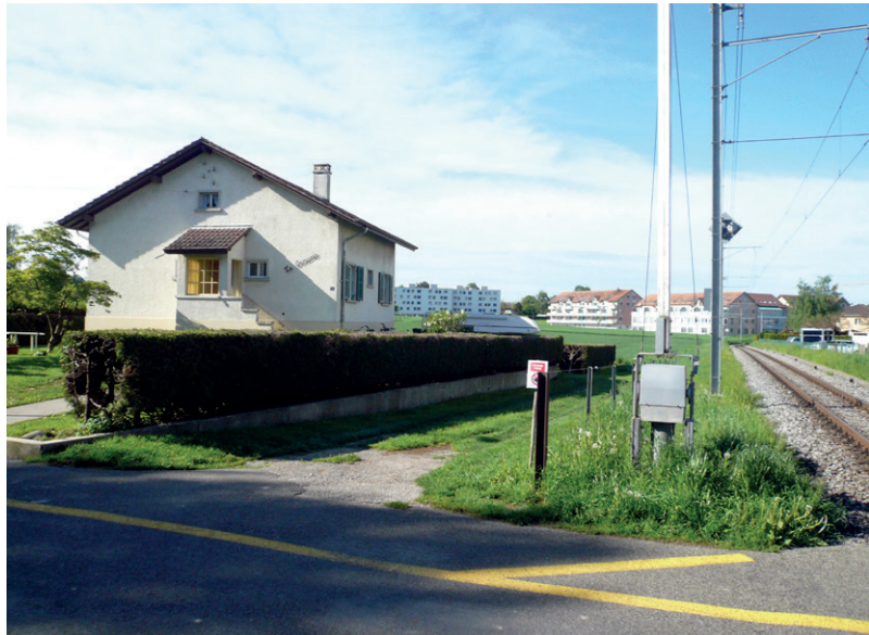
Fig. 5-19: Des bâtiments résidentiels en R+3/R+4 ont été implantés en bordure des terres agricoles (arrière plan), proche de la gare du LEB Sur Roche , à Echallens, 2015 © JD
