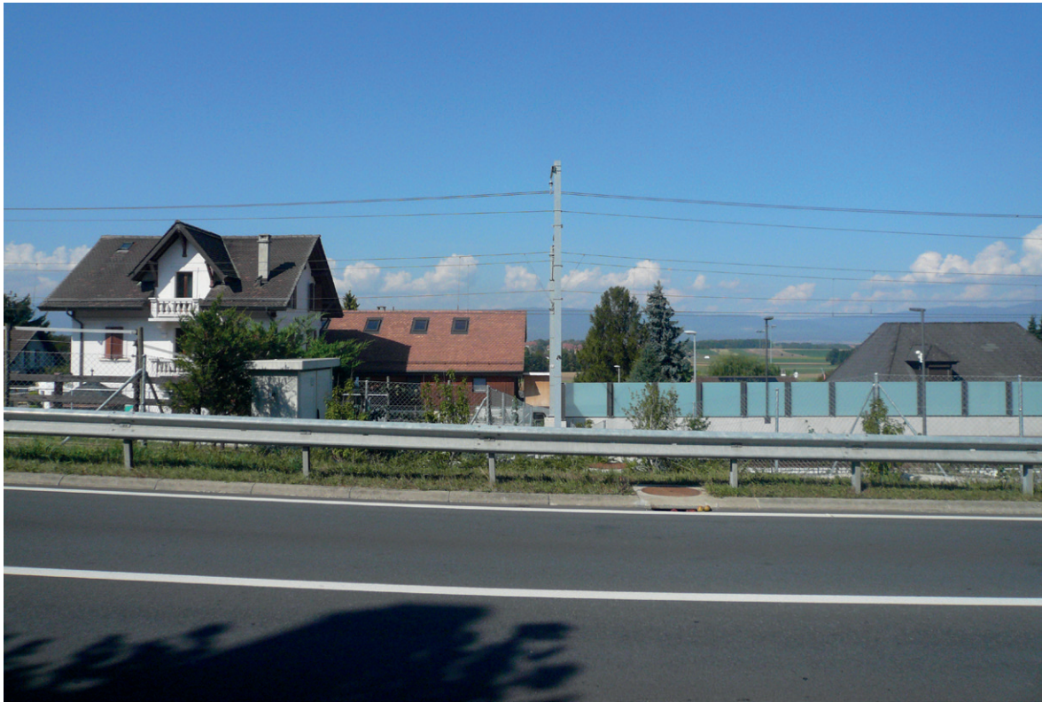
Fig. 6-23: Vue depuis l'est, au-delà de la route cantonale et des voies ferrées du LEB 20 septembre 2018 © JD
