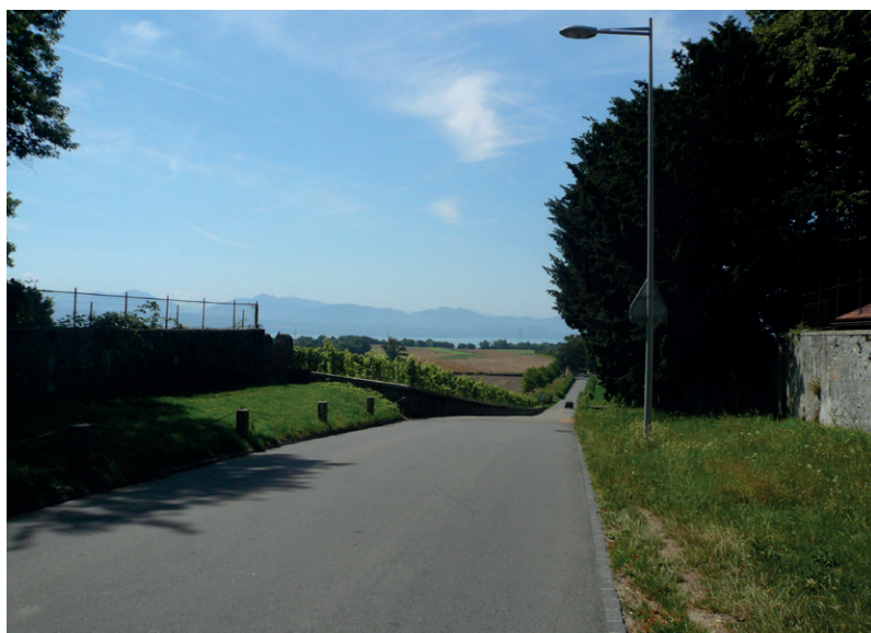
Fig. 5-3: Route Le Pavé entre le bourg de Saint-Saphorin et la route cantonale. Aucun aménagement n'est prévu pour les usagers non automobilistes. Échichens, 4 août 2016, © JD.
