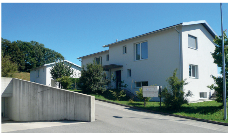
Fig. 5-8: Exemples d'opérations de maisons à deux logements réalisées depuis 2010 dans les quartiers périurbains de maisons individuelles, Échichens, Savigny, 2017, © JD.
