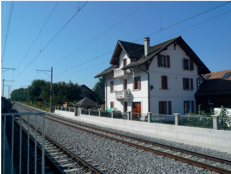
Fig. 6-25: Réaménagement de la gare du LEB à Assens entre le 8 mai 2015 et le 20 septembre 2018. © JD
