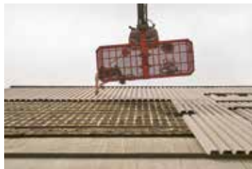
Extraction de tôles métalliques à Lysbüchel, Bâle (© MARTIN ZELLER)
